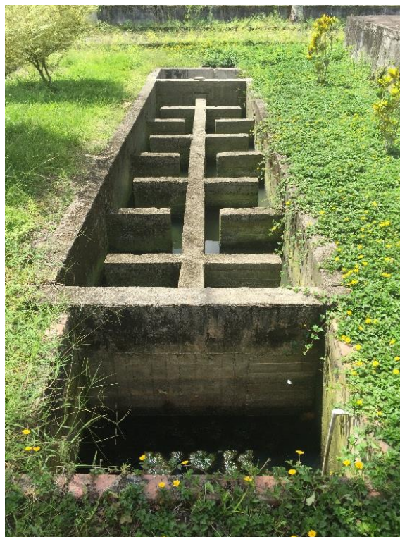
Ilustración 7 Canal De Contacto De Cloro; Tomada por Empresas de servicios públicos del Meta (EDESA S.A E.S.P., 2016)
