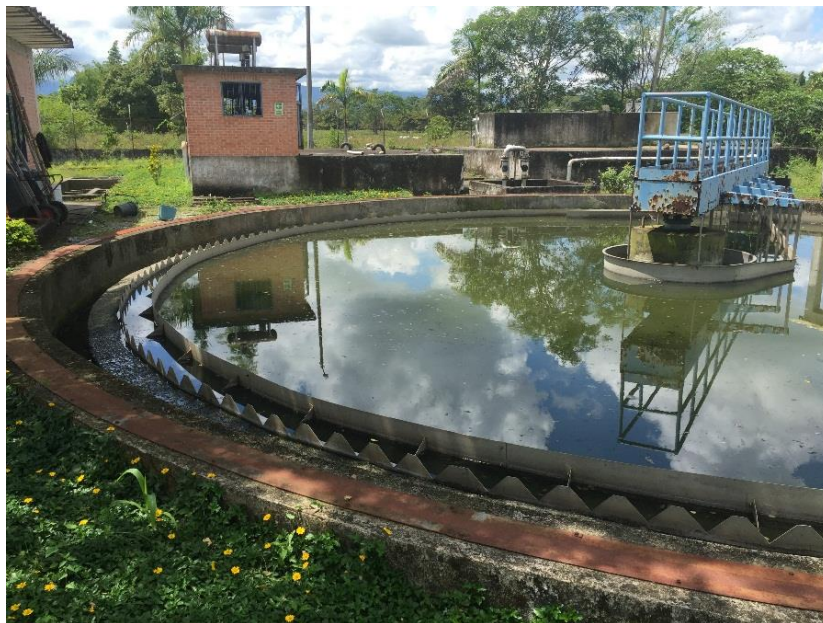
Ilustración 5 Barredor De Lodos; Tomada por Empresas de servicios públicos del Meta (EDESA S.A E.S.P., 2016)
