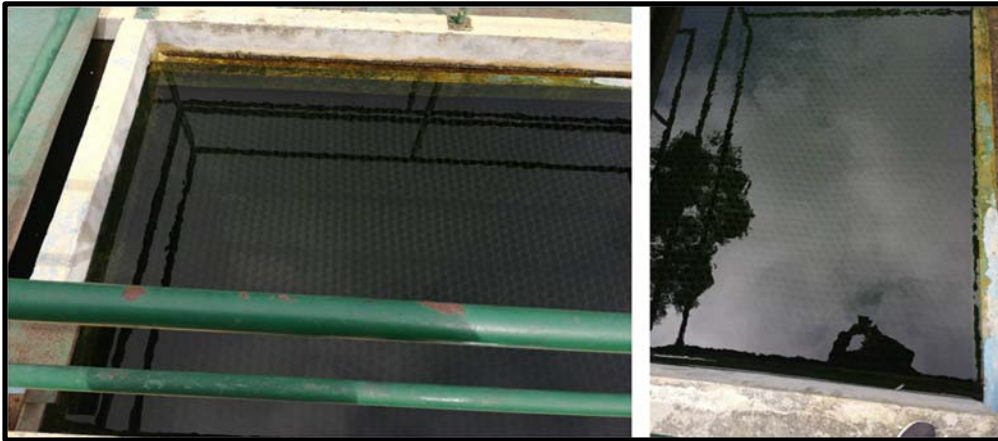
Figura 14. Sedimentador de alta tasa
