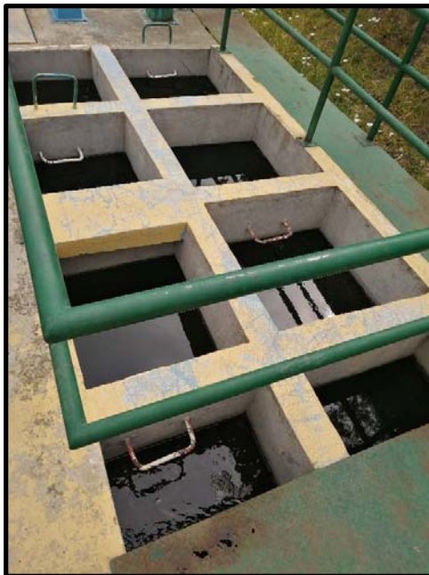
Figura 13. Floculadores tipo cox
