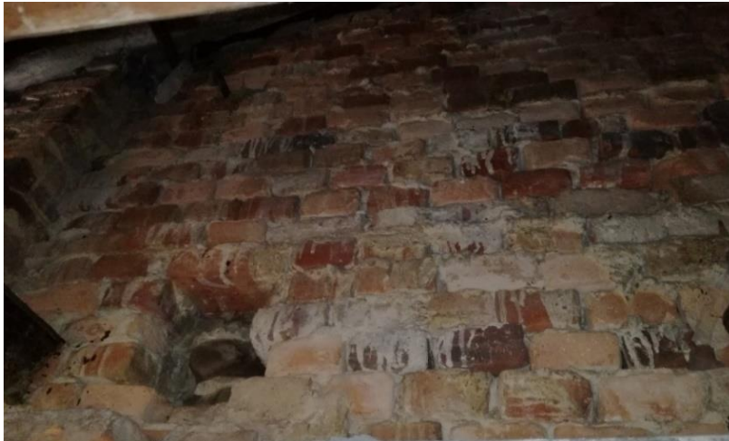
Figura 6-4. Armado de muro en adobe del Edificio Nacional.
