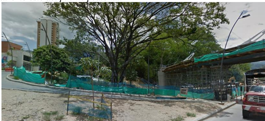
Figura 73. Extremo este del puente peatonal.
