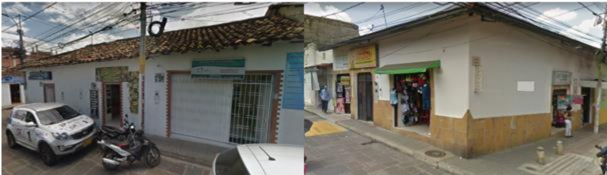
Figura 52. Tipología de casas del Casco Antiguo con rasgos coloniales.
