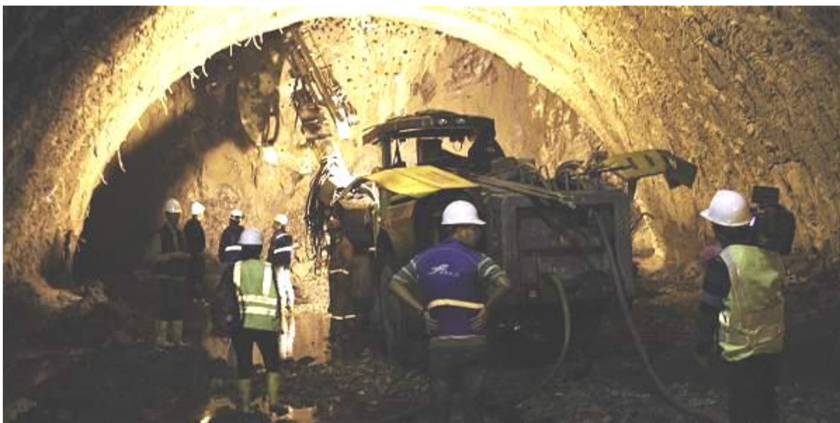
Figura 54 Reinicio de construcción de túnel de la línea, método de perforación, INVIAS, 2.015.
