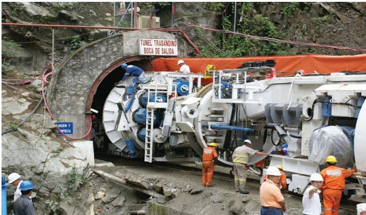
Figura 23 TBM utilizada en los Andes Peruanos. Desiree, 2.012.
