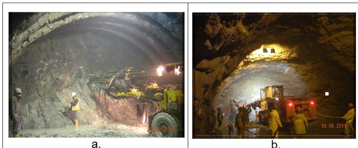
Figura 57 Frentes Quindío y Tolima – Túnel Segundo Centenario, Cámara Colombiana de la infraestructura, 2.011.
