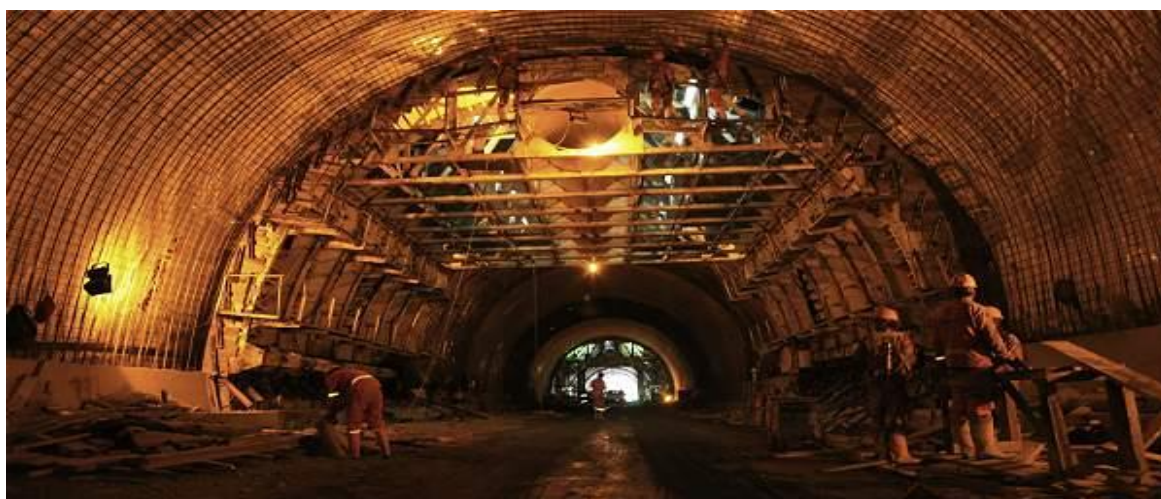
Figura 61 Construcción de arcos en túnel de la línea, recubrimiento, INVIAS, 2.015.
