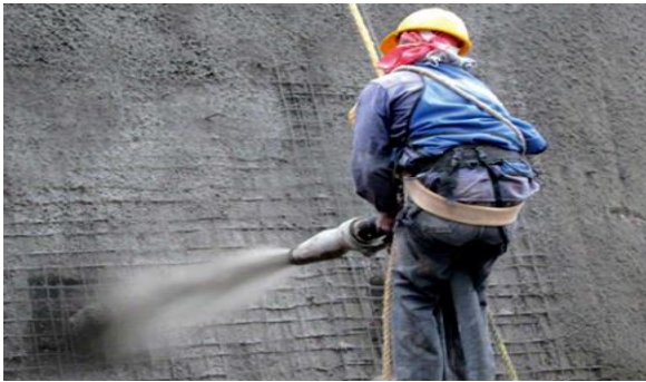
Figura 38 Concreto lanzado, Ochoa, 2.014.
