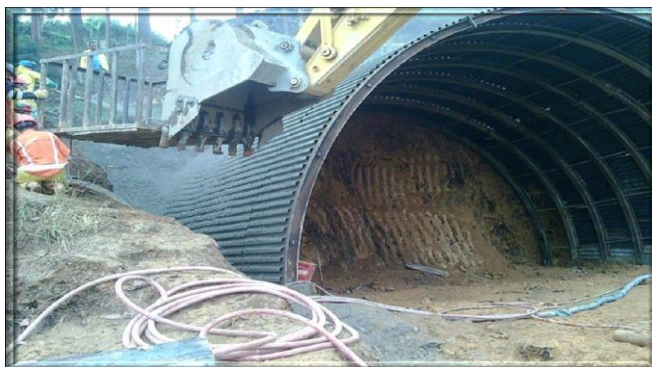
Figura 59 Construcción del Túnel RCN, Cámara Colombiana de la Infraestructura, 2.011.
