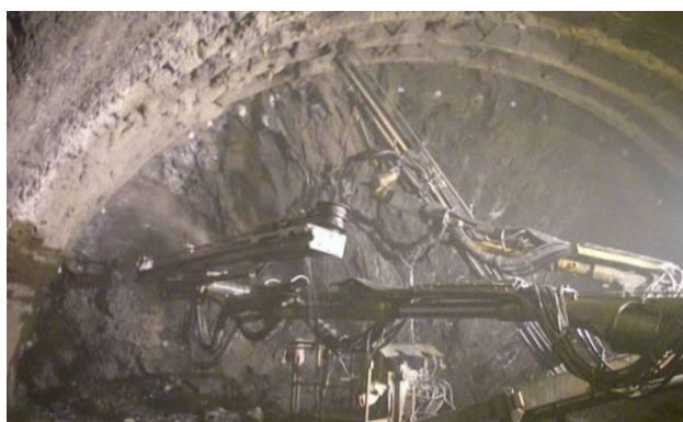
Figura 58 Instalación de pernos radiales - Galería No 8 hacia Tolima, INVIAS 2.012.
