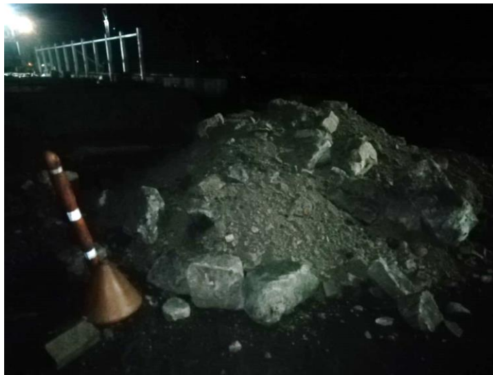
Imagen 6: Acopio de piedra rajón para mejoramiento de Main Tunel.
