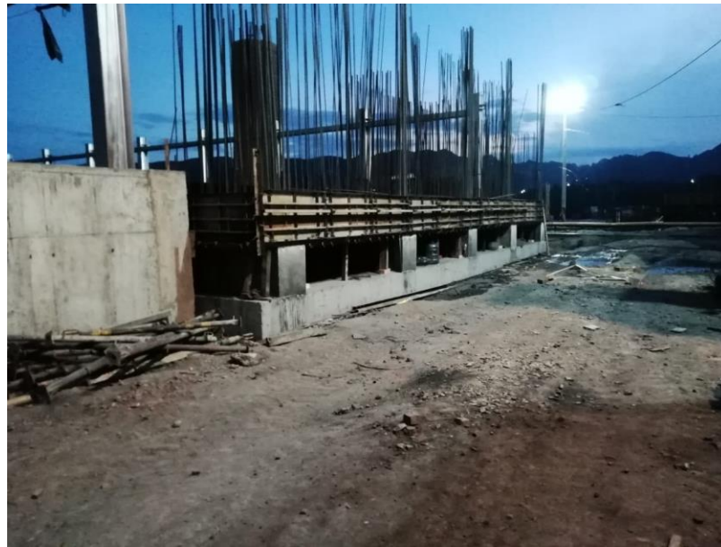
Imagen 4: Amarre de acero para viga 2 de muro de contención.
