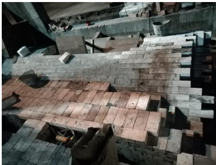
Imagen 3: instalación de mampostería para cúpula en ducto WHT.
