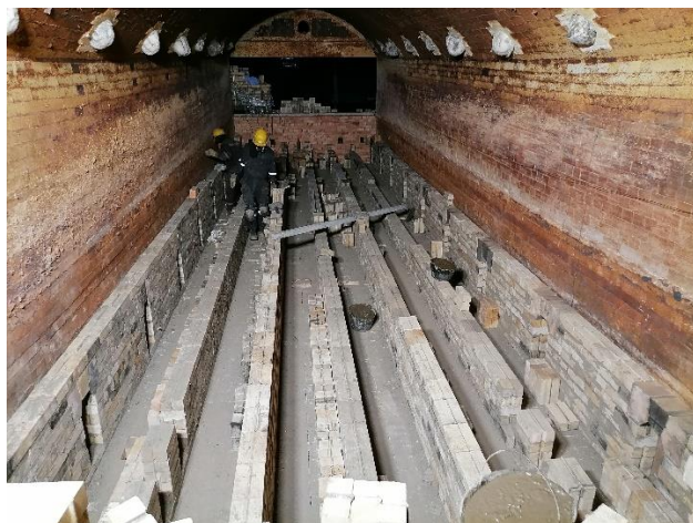
Imagen 10: instalación de muros y puentes de soleras horno 48.
