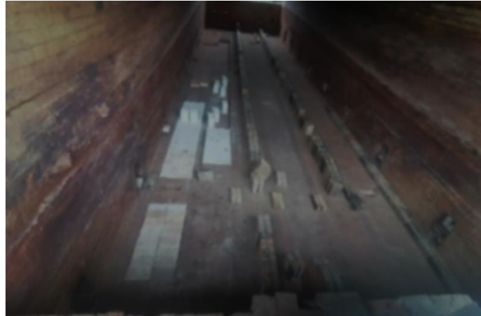
Imagen 8: instalación de mampostería en muros de solera horno 48.
