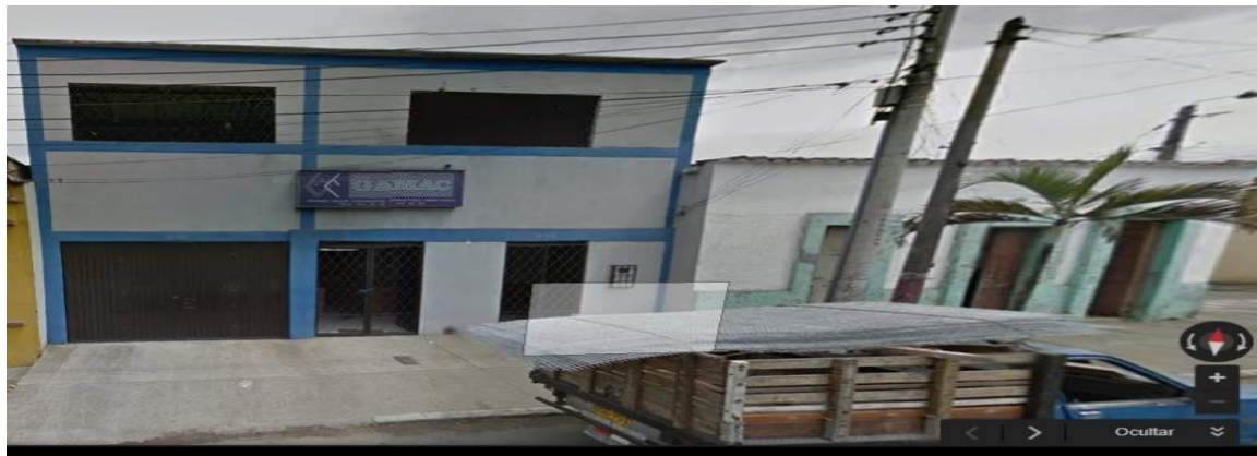
Figura 3 Fachada de Gamac Colombia S.A.S
