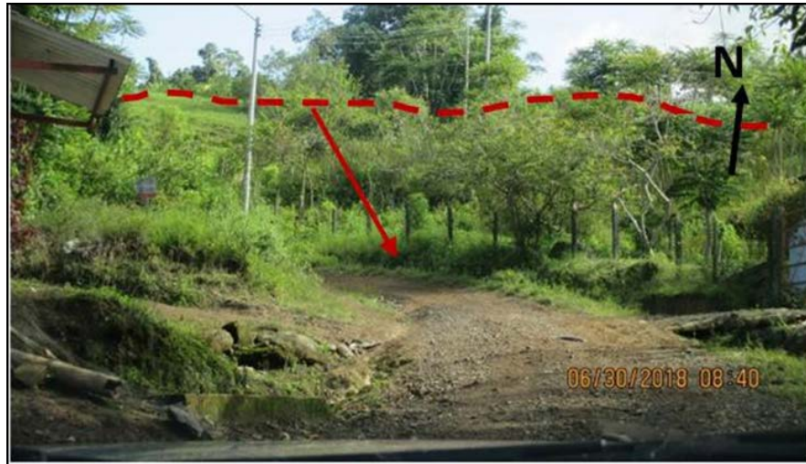
Ilustración 67. Aspectos de proceso superficial de reptación Ubicado en laderas superiores del carretable inter-veredal e intermunicipal al oriente y en los alrededores de la concentración Rural de San Pedro, (Punto de control EO-3) Fuente: Geocing S.A.S.
