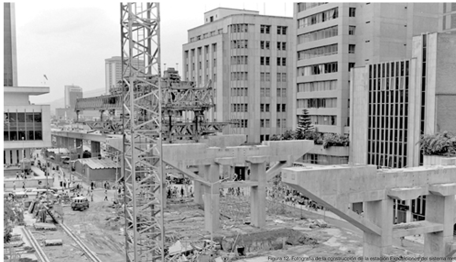
Figura 12. Fotografía de la construcción de la estación Exposiciones del sistema metro
