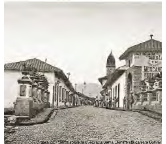
Figura 28. Puente sobre la quebrada Santa Elena en la carrera Bolívar
