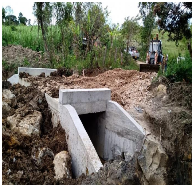
Figura 4 Construcción Box Culvert
