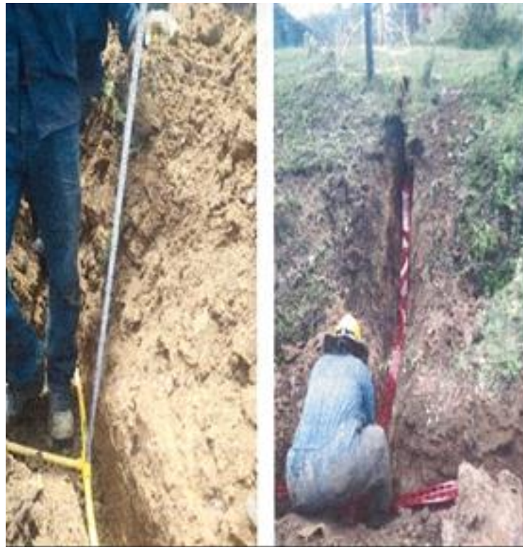
Figura 14 Instalación red interna
