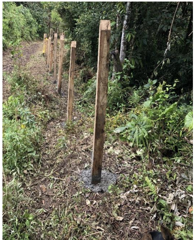
Figura 12 Anclaje barras de madera
