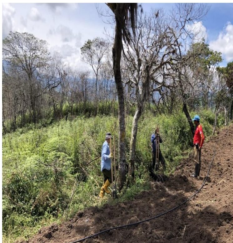
Figura 10 construcción de Cerramiento
