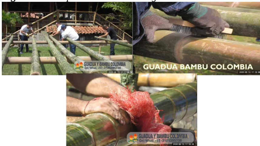
Figura 117. Limpieza de las cañas de guadua.
