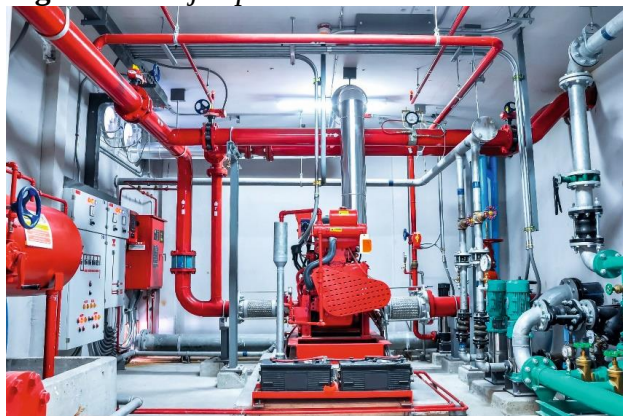
Figura 235. Ejemplo de cuarto de bombas contra incendios.
