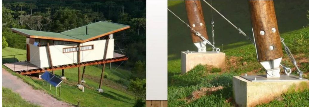
Figura 129. Tipo de unión metálica de base articulada.
