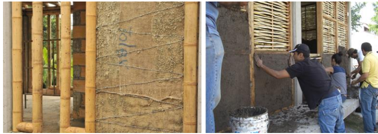
Figura 157. Imágenes de proceso de construcción de muro de bahareque enjaulado.
