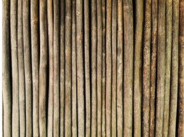
Figura 171. Cerramiento amarrado de varas de palma de corozo de lata.
