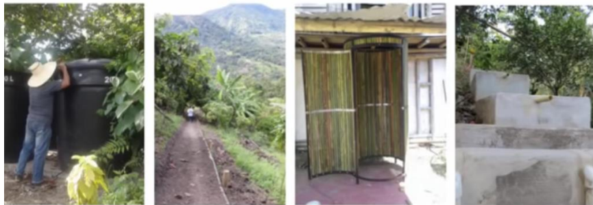
Paralelo a todas las obras se realizaron adecuaciones de la finca: Tanques de almacenamiento para 33.000 litros, senderos, biofiltro para tratamiento de aguas grises, baños secos y duchas externas en bambú, canalizaciones, acometida eléctrica, entre otros.
