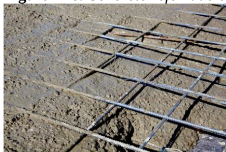
Figura 176. Concreto reforzado en obra.
