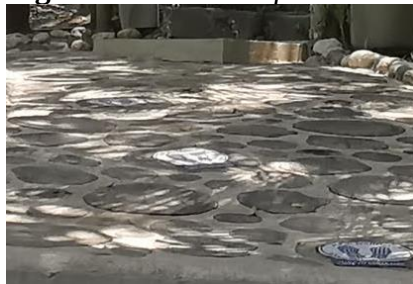
Figura 179. Piso de piedra de río con mortero de cal.
