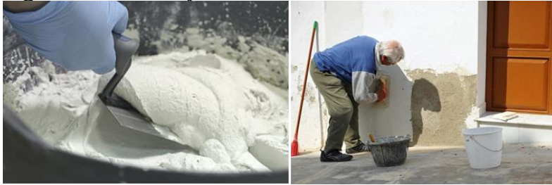
Figura 177. Mezcla y acabado de mortero de cal.
