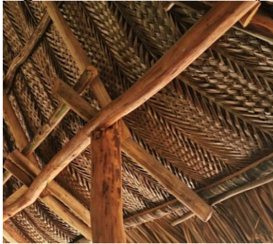
Figura 172. Cielo raso de tejido de hoja de palma de vino o coco sobre parales de madera.
