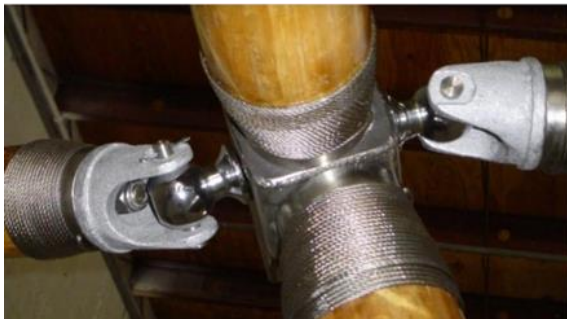
Figura 187. Detalle de Unión Metálica de Platinas de Aluminio Articuladas.
