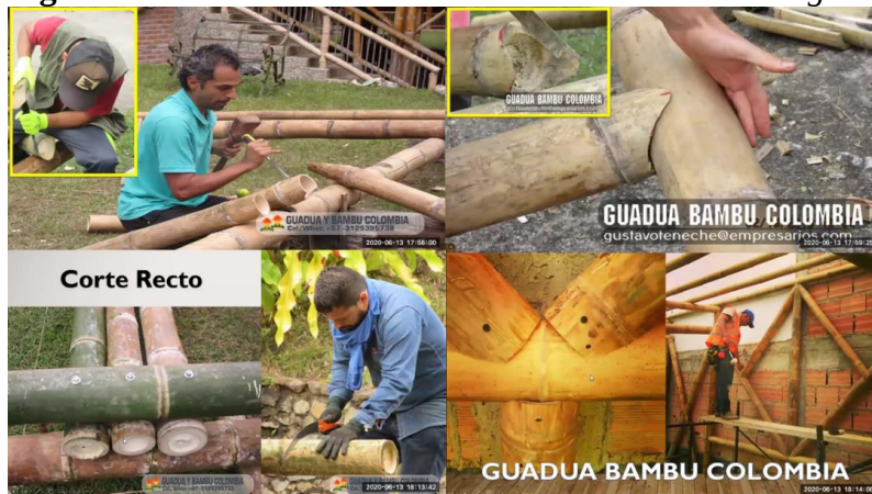
Figura 128. Proceso en obra de los cortes básicos de la guadua.
