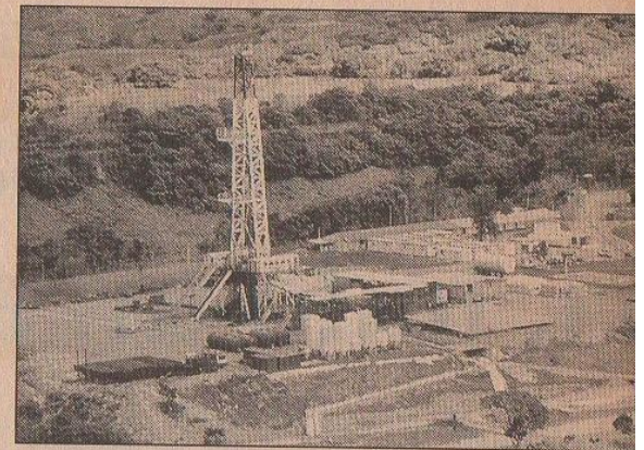
Este es uno de los 15 pozos que se están perforando donde hay reservas cercanas a los 500 millones de barriles.
