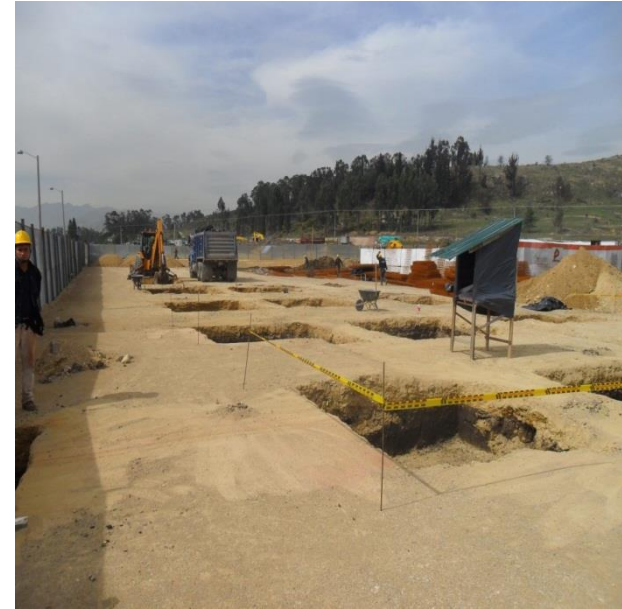
Excavación para zapatas
