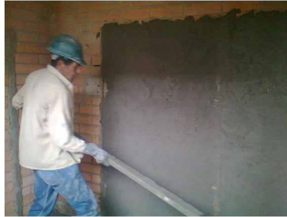
Pañete de muros
