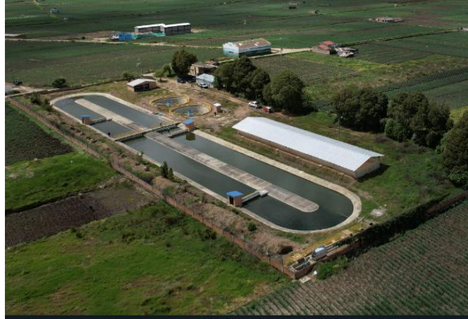
Imagen 16. Vista general PTAR Aquitania
