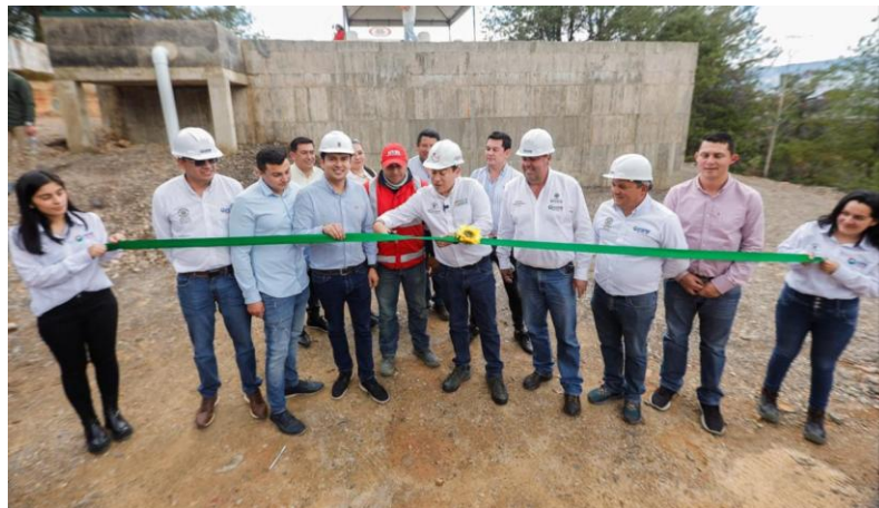
Fuente: Tomado de Informe de Empalme EPB (2025).
