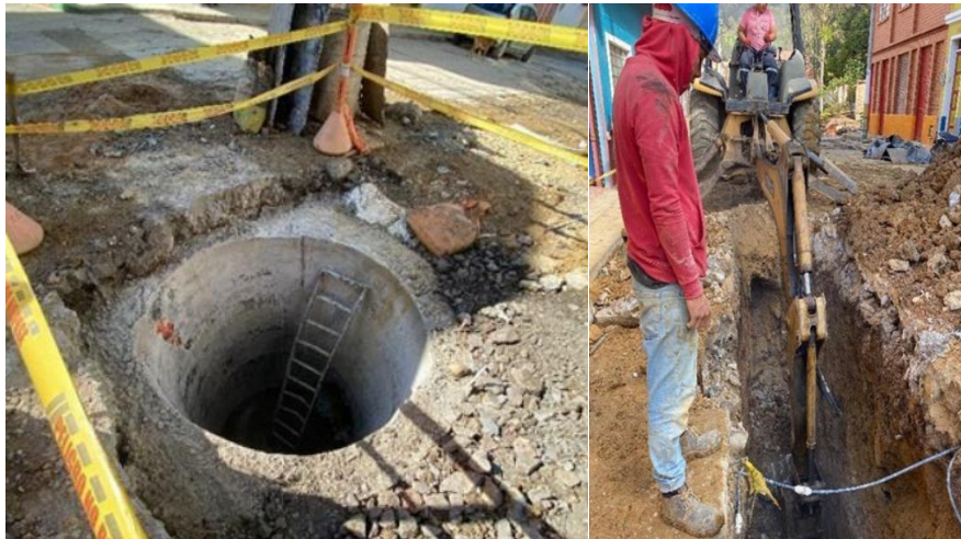
Imagen 8. Alcantarillado de Chinavita
