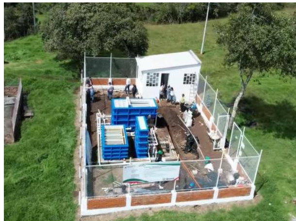
Fuente: Tomado de Informe de Empalme EPB (2025).
