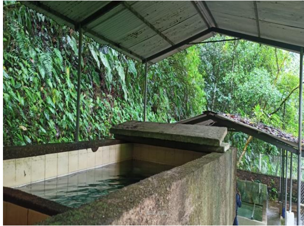
Fuente: Tomado de Informe de Empalme EPB (2025).
