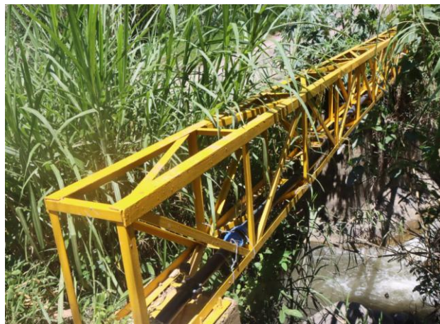
Fuente: Tomado de Informe de Empalme EPB (2025).
