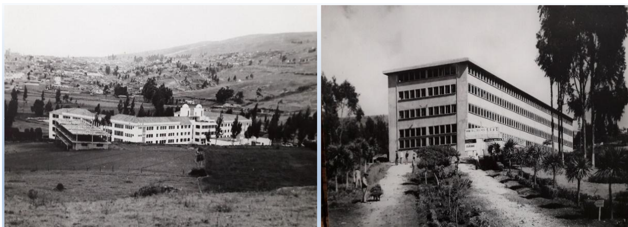
Figura 35. Periodo de construcción del Edificio Laboratorios. Adaptadas del archivo fotográfico de la U.P.T.C, 1957.
