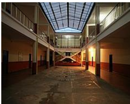
Figura 41. Fotografía del edificio Escuela Normal de Varones desde patio interno. Elaboración propia, 2016.
