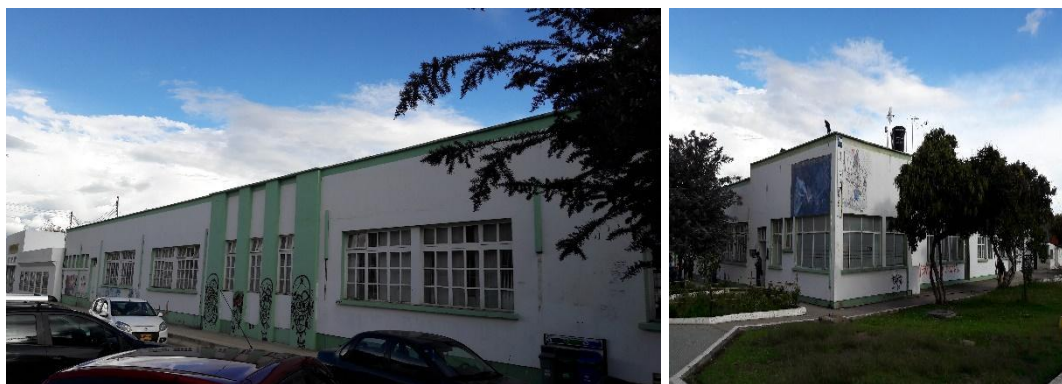
Figura 46. Fotografía de fachada lateral para edificio Bienestar Universitario desde fachada frontal. Elaboración propia, 2016.
