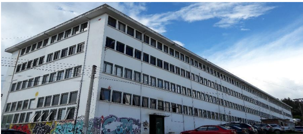
Figura 34. Fotografía del edificio Laboratorios desde fachada posterior. Elaboración propia, 2016.
