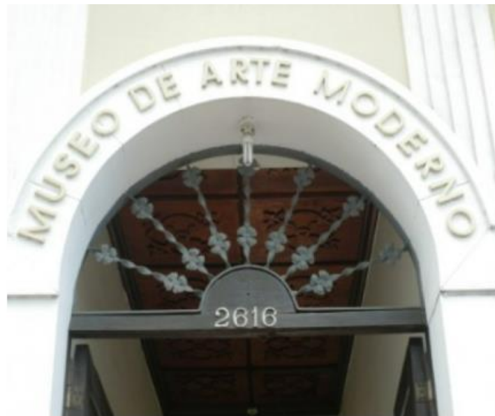
Figura 47. Detalle de arco en puerta
