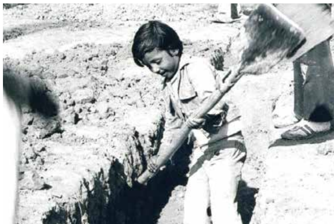
Figura 17. Adecuación zanja para alcantarillado, barrio Nuevo Chile, Bogotá D.C.
