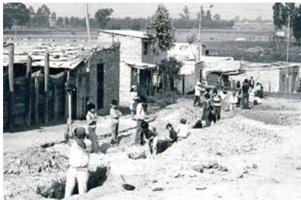
Figura 15. Construcción alcantarillado Calle 56, barrio Nuevo Chile, Bogotá D.C.
