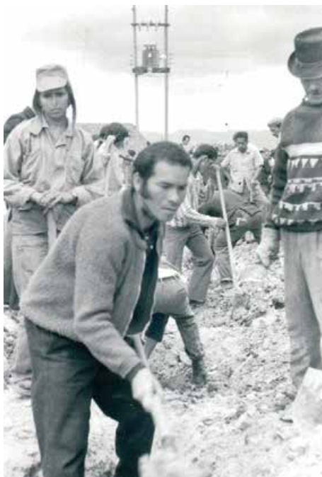
Figura 16. Construcción del alcantarillado, barrio Nuevo Chile, Bogotá D.C.
