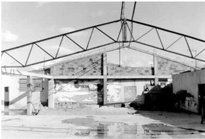
Figura 10. Construcción Casa cultural barrio Nuevo Chile, Bogotá D.C.
