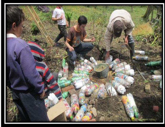
Foto N° 32 y 33. Sobre el cemento se pone la primera capa de botellas, y se asegura con alambre sujetando las botellas a las varillas metálicas.
