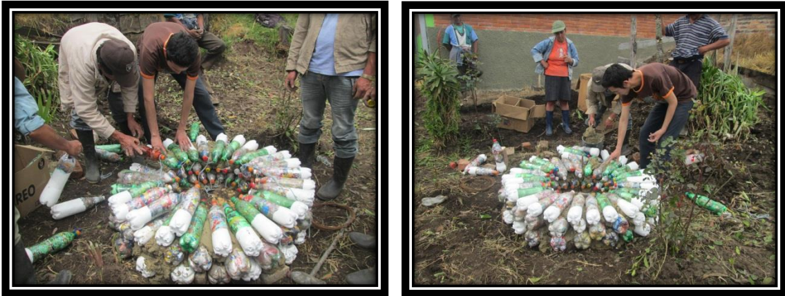
Foto N° 36 y 37. Se pone la última capa de botellas para la materia, ajustando las botellas con el alambre.
