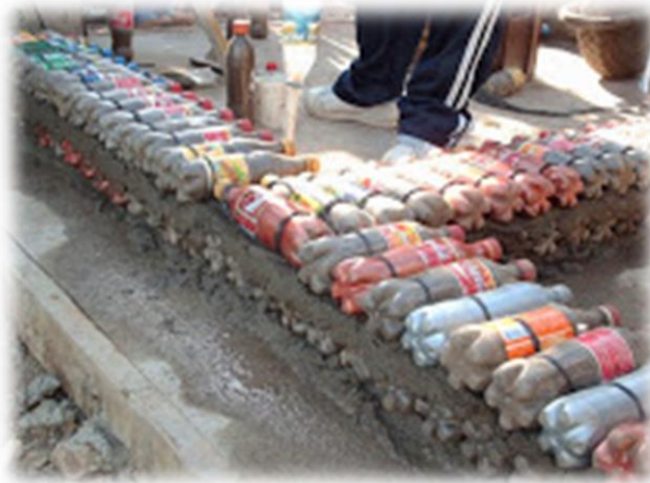
Imagen N° 11, construcciones bases para vivienda, mediante la reutilización de botellas plásticas, en honduras.
