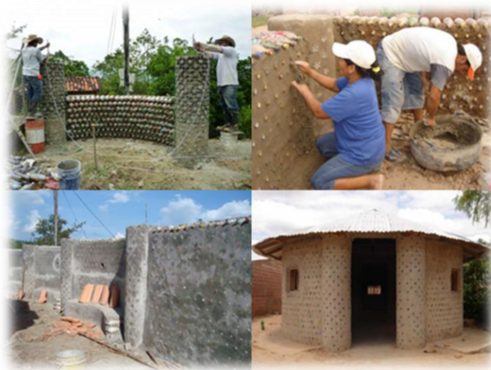
Imagen N° 10, construcciones de vivienda, mediante la reutilización de botellas plásticas PET, esta vivienda fue elaborada en Bolivia.
