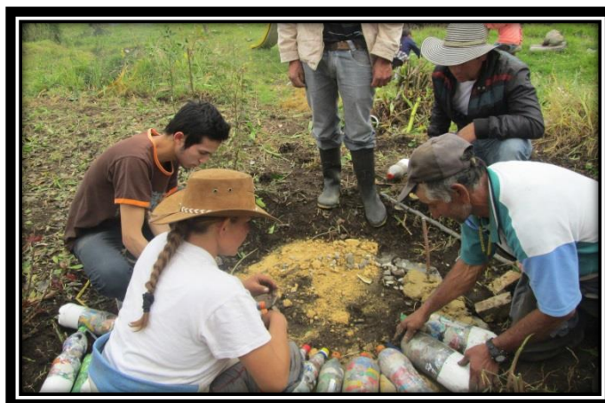
Foto N° 27. Luego de haber puesto los trozos de piedra se aplicó una capa de arena alrededor.
