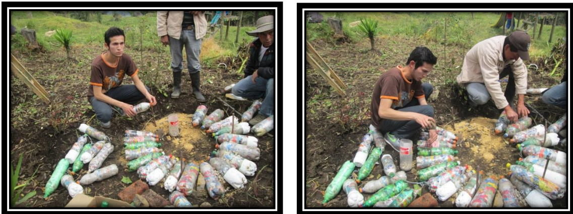
Foto N° 30 y 31. Se clavan las varillas metálicas en este caso se utilizaron 6, se aplica una capa de cemento, y se ponen las botellas aplicando una leve presión.
