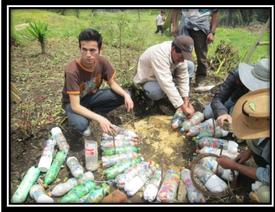
Foto N° 32 y 33. Sobre el cemento se pone la primera capa de botellas, y se asegura con alambre sujetando las botellas a las varillas metálicas.
