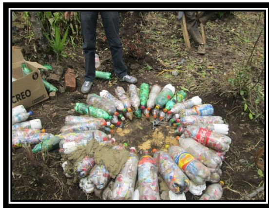
Foto N° 34 y 35. Se pone la segunda capa de botellas para aumentar la altura de la matera, ajustando las botellas con el alambre.
