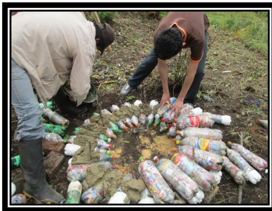
Foto N° 34 y 35. Se pone la segunda capa de botellas para aumentar la altura de la matera, ajustando las botellas con el alambre.
