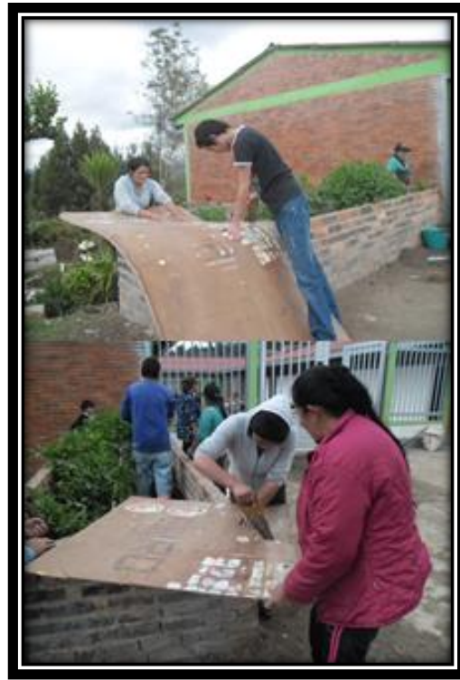
Foto N° 48 y 49. Corte de tablas y lámina de madeflex (Ver Anexo N° 25 CD mas fotos).
