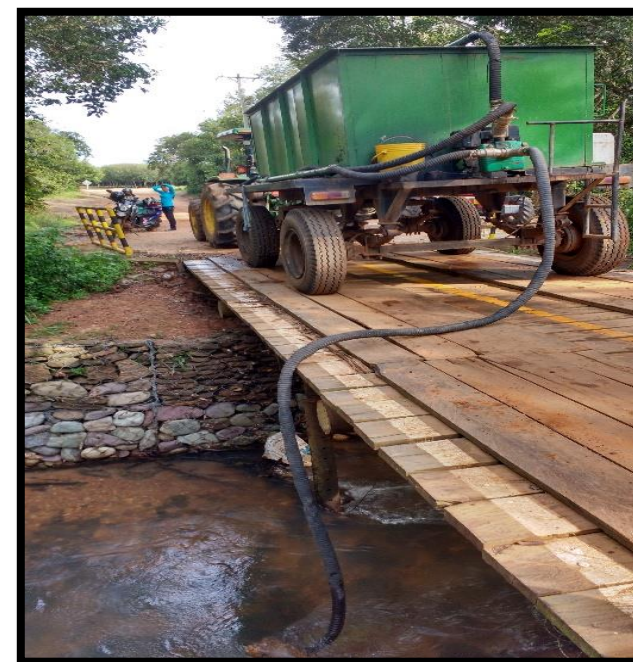
Sistema de captación por "agua móvil"
