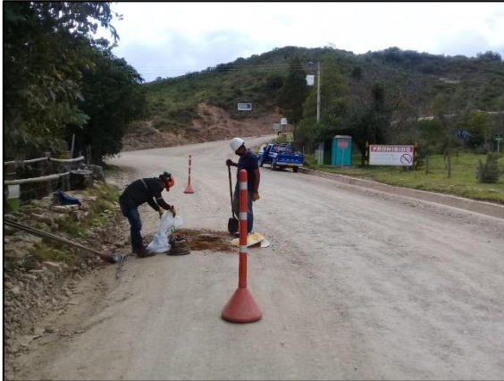
Fotos No. 3 y 4. Localización Apique 2, km0+410.
