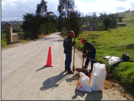
Fotos No. 1 y 2. Localización Apique 1, km0+060.
