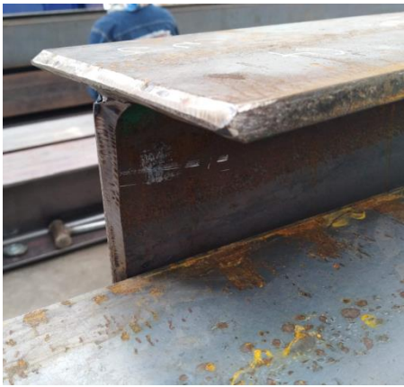
Imagen 31: Preparación de la junta, Biselado del perfil
