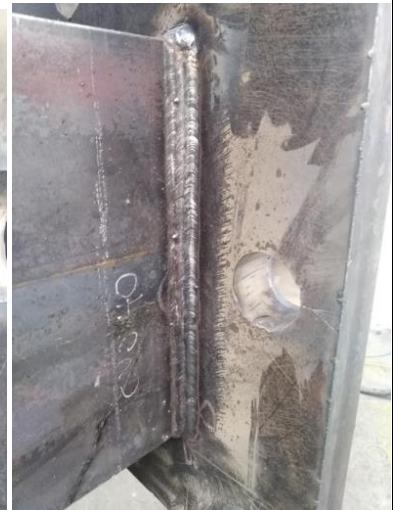
Imagen 38: Chequeo del cordón de soldadura.
