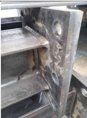
Imagen 34: Chequeo del cordón de soldadura.
