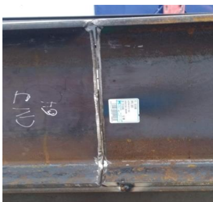
Imagen 28: Junta de Columna
