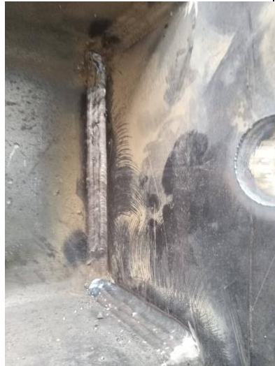
Imagen 37: Chequeo del cordón de soldadura.
