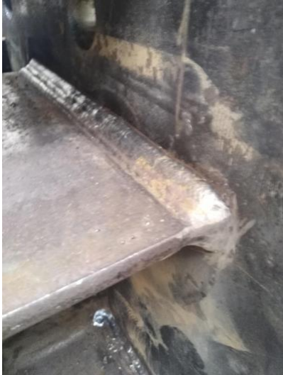
Imagen 36: Chequeo del cordón de soldadura.
