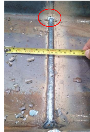
Imagen 33: Chequeo del cordón de soldadura.
