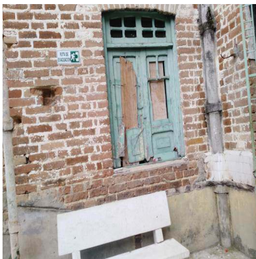
Figura 22 Fachadas en mampostería estructural. Fuente Propia
