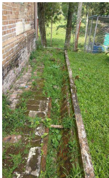
Figura 9 Cunetas perimetrales. Fuente Propia|
