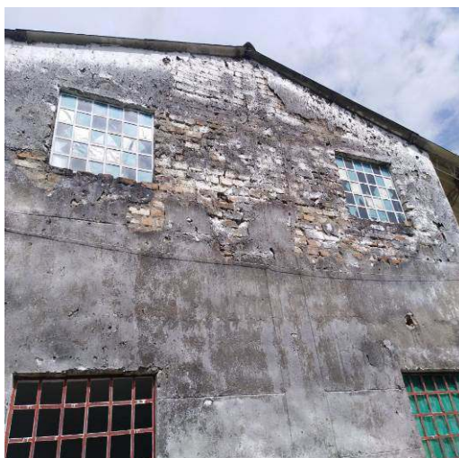
Figura 21 Fachadas en mampostería estructural. Fuente Propia
