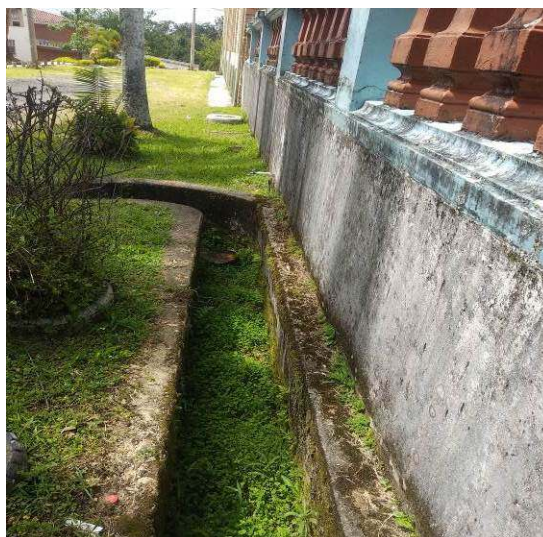
Figura 20 Estructuras exteriores. Fuente Propia
