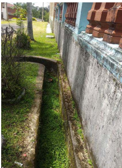
Figura 8 Cunetas perimetrales. Fuente Propia|
