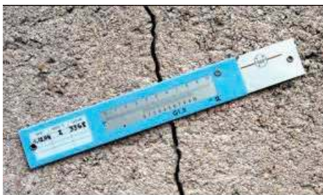
Figura 37 Fisurómetro. (Patología + Rehabilitación + Construcción., 2021)
