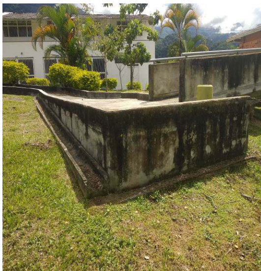
Figura 19 Estructuras exteriores. Fuente Propia
