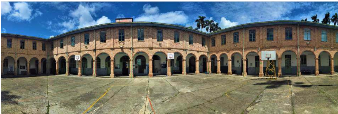
Figura 6 Arco Medio Punto. Fuente Propia
