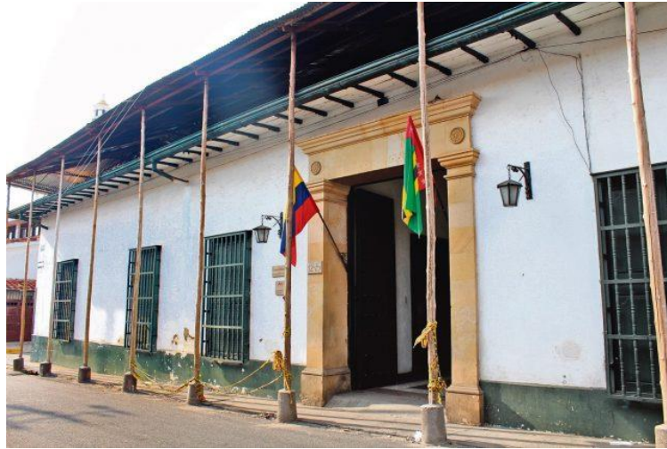
Figura 12. Casa de Bolívar actualidad
