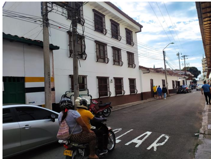
Figura 53. Estado actual entre calles 37 y 41
