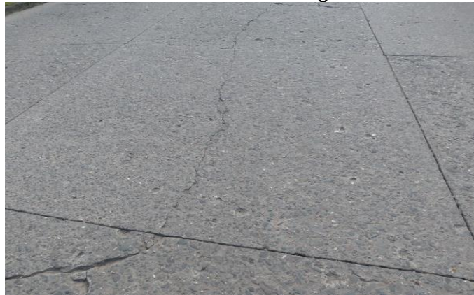
Ilustración 9 Grieta Longitudinal
