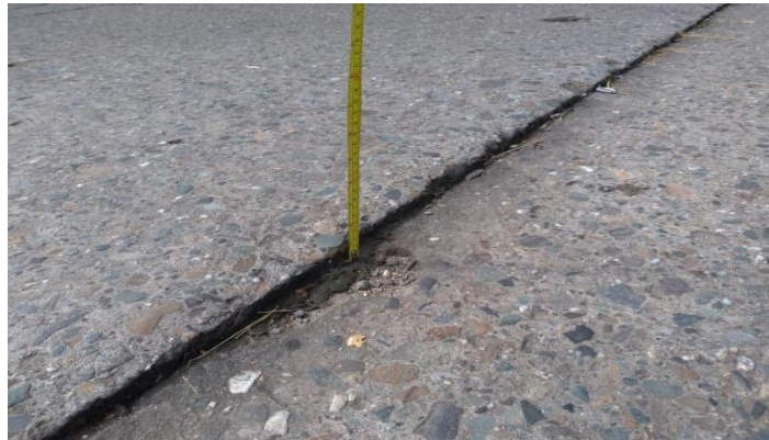
Ilustración 22. Hundimiento
