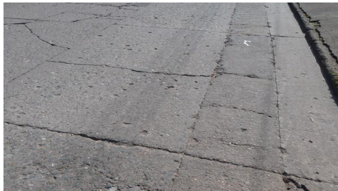
Ilustración 8 Grieta Transversal
