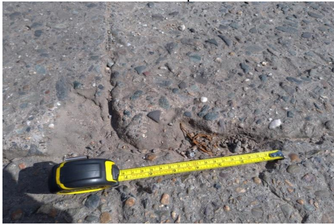
Ilustración 18 Desportillamiento
