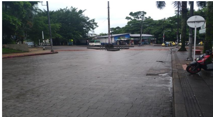
Ilustración 6 Tramo vial Calle 35- Calle 37. Concreto estampado
