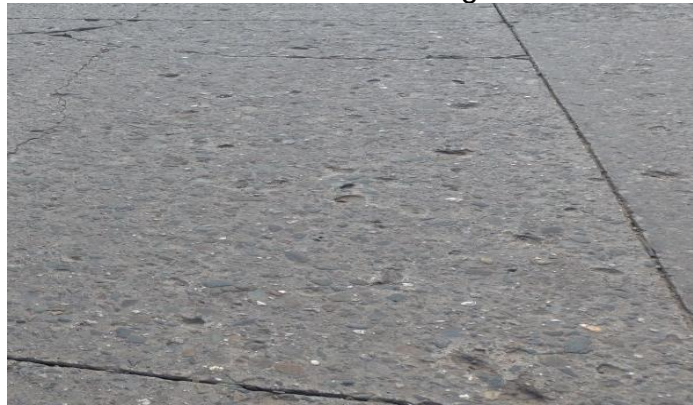
Ilustración 20. Desintegración
