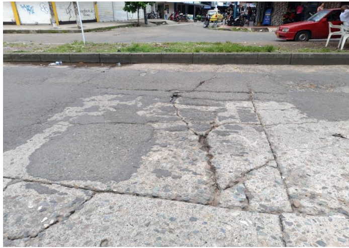
Ilustración 25. Levantamiento localizado
