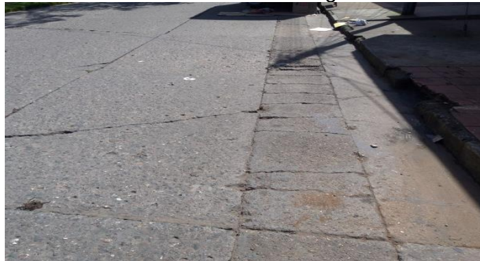
Ilustración 12 Parche longitudinal
