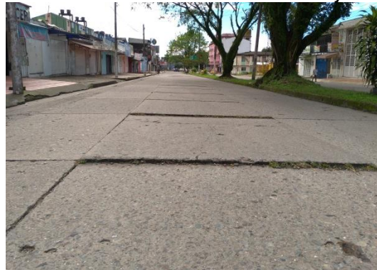
Ilustración 17 Escalonamiento de juntas
