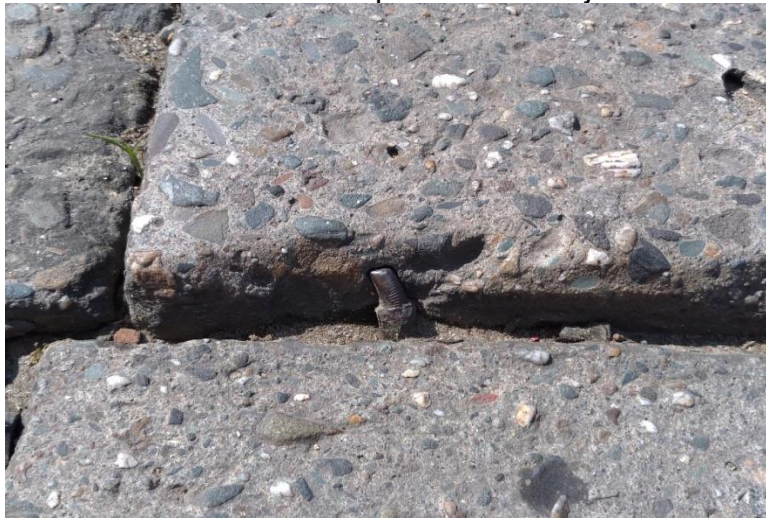
Ilustración 21. Separación de la junta
