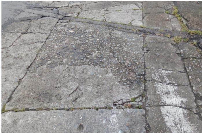
Ilustración 24 Descascaramiento
