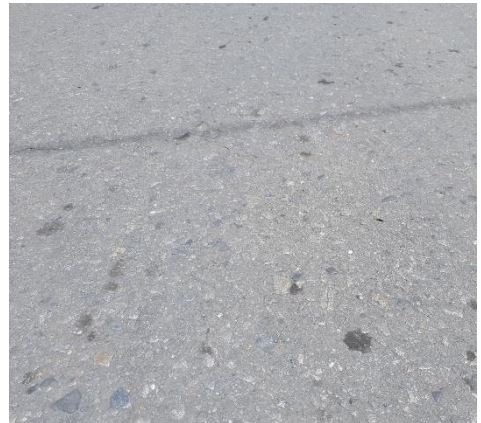
Fotografía 7. Pulimiento del Agregado
