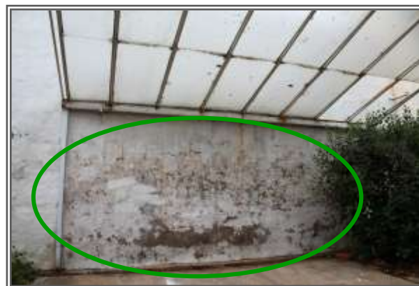
FIGURAS N. 36 y 37. Lesiones identificadas a nivel de muros en los espacios E1-6 y E1-8 respectivamente. Fuente: Grupo de investigación.
