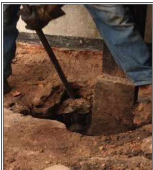
FIGURA N. 82. Proceso excavación apiques Casona Francisco Mariño. Fuente: Grupo de investigación.
