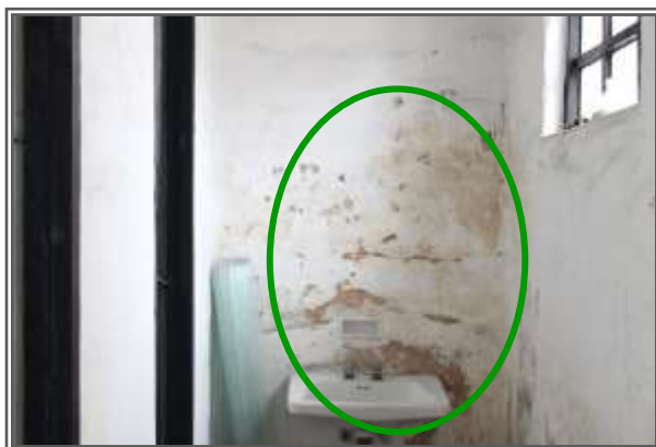
FIGURAS N. 36 y 37. Lesiones identificadas a nivel de muros en los espacios E1-6 y E1-8 respectivamente. Fuente: Grupo de investigación.
