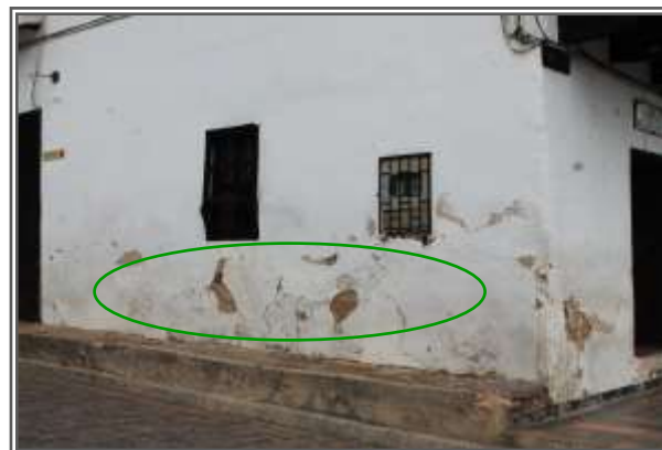
FIGURAS N. 34 y 35. Lesiones identificadas a nivel de muros a nivel de fachadas. Fuente: Grupo de investigación.
