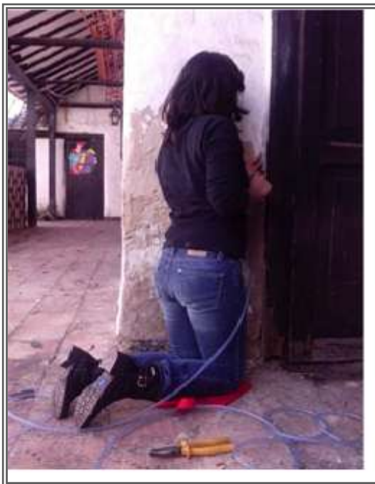
FIGURA N. 85. Proceso levantamiento de niveles y levantamiento arquitectónico Casona Francisco Mariño. Fuente: Grupo de investigación.
