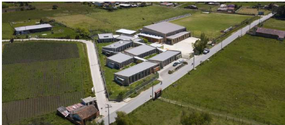
Figura 38. Vista de la casa
