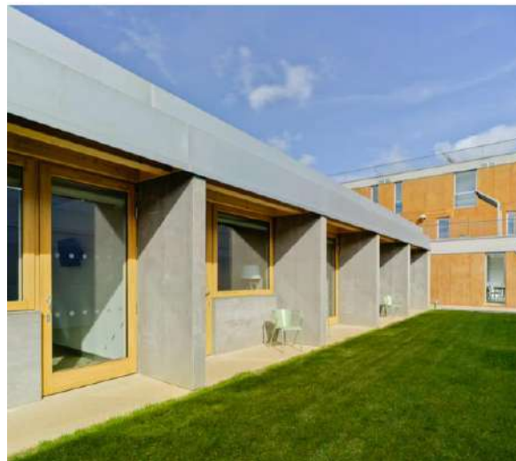
Figura 41. Vista Patios internos habitaciones
