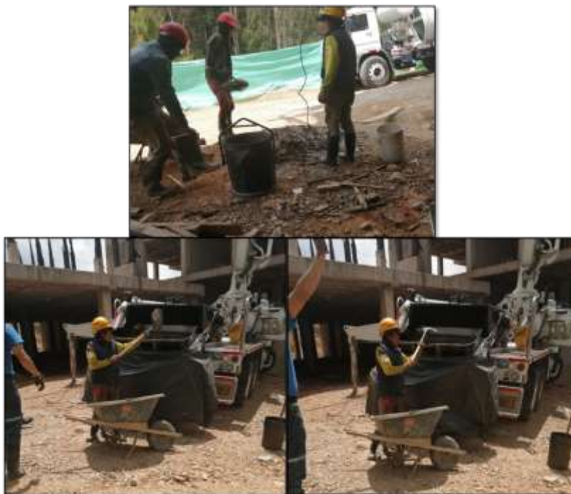
Ilustración 22: Concreto de limpieza o purga.
