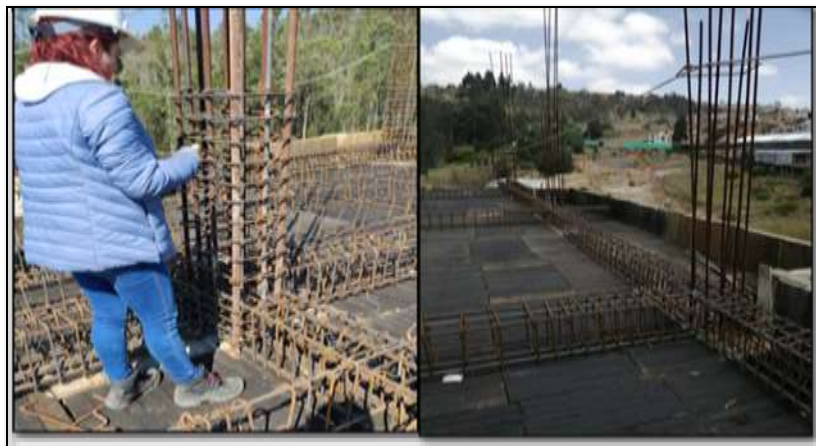
Ilustración 14: Arranque de columnas con flejes, ganchos y aceros longitudinales.
