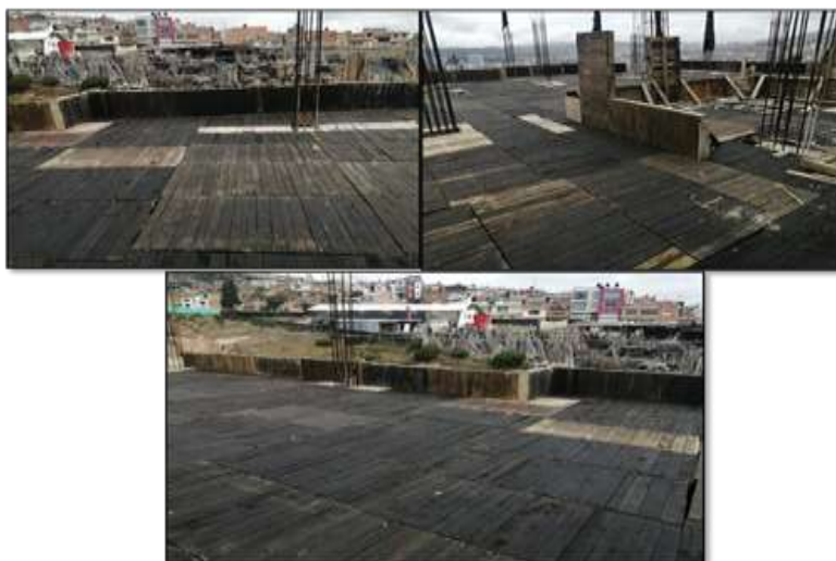
Ilustración 7: Camillas para la losa de entrepiso nivel 7.
