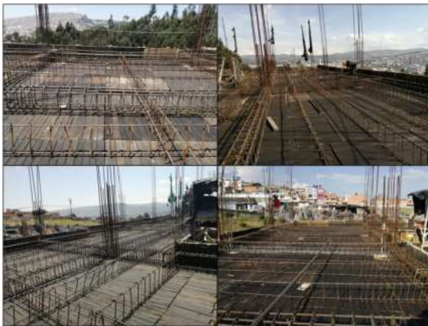
Ilustración 16: Riostras y viguetas armadas (10x40)
