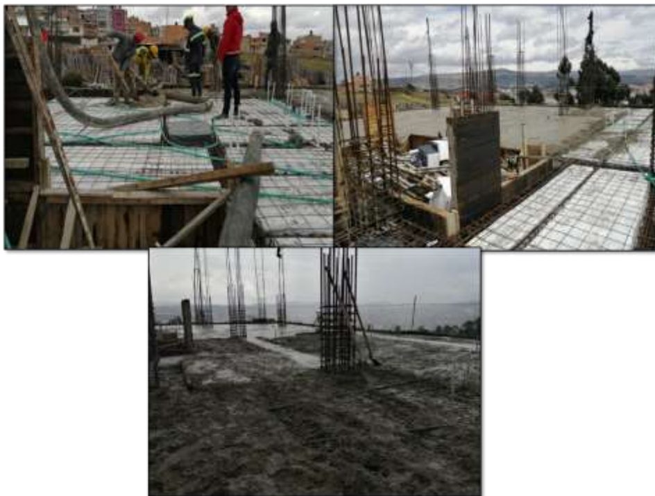
Ilustración 27: Proceso de vaciado ya finalizado
