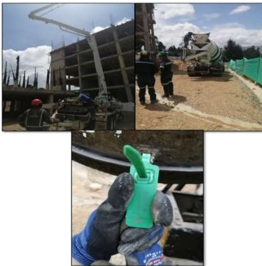
Ilustración 21: Llegada del concreto a obra.
