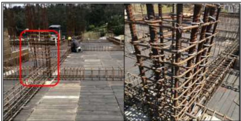
Ilustración 13: Proceso de armado de vigas y arranque de columnas
