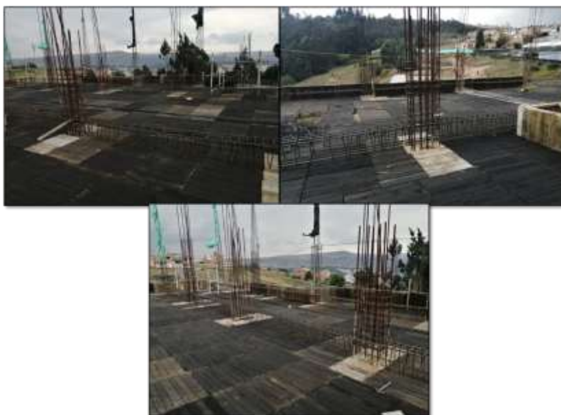
Ilustración 11: Armado de viga 430, 423, 432 (35x40)
