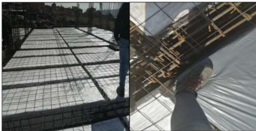
Ilustración 19: Malla instalada en la losa
