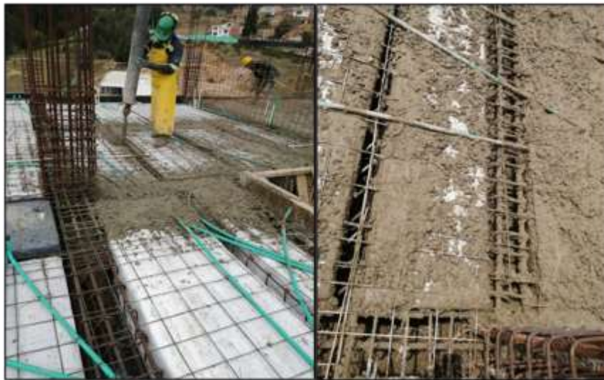
Ilustración 26: Proceso de vaciado
