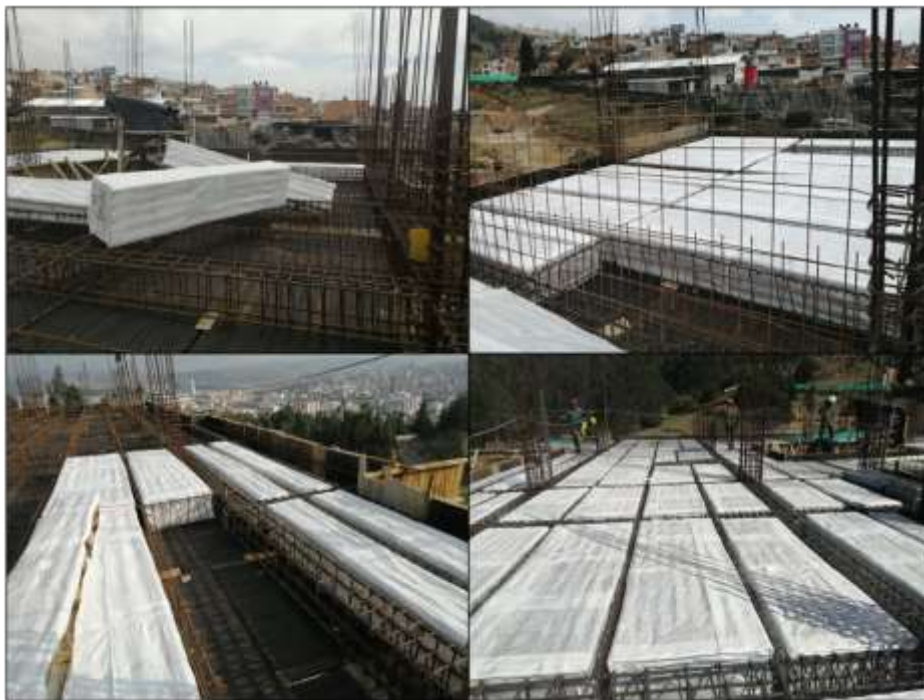
Ilustración 18: Casetones instalados en la losa
