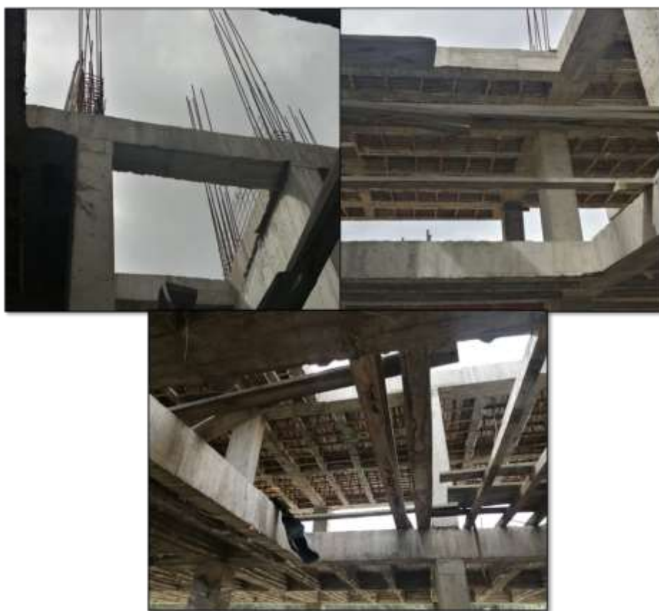
Ilustración 28: Vista de losa con casetones
