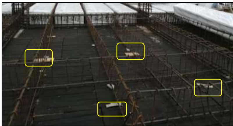
Ilustración 8: Lamina de madera, evita filtraciones
