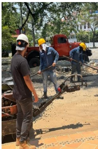
Figura 6 Reposición en pavimento flexible contrato de obra No. 308 de 2023.
