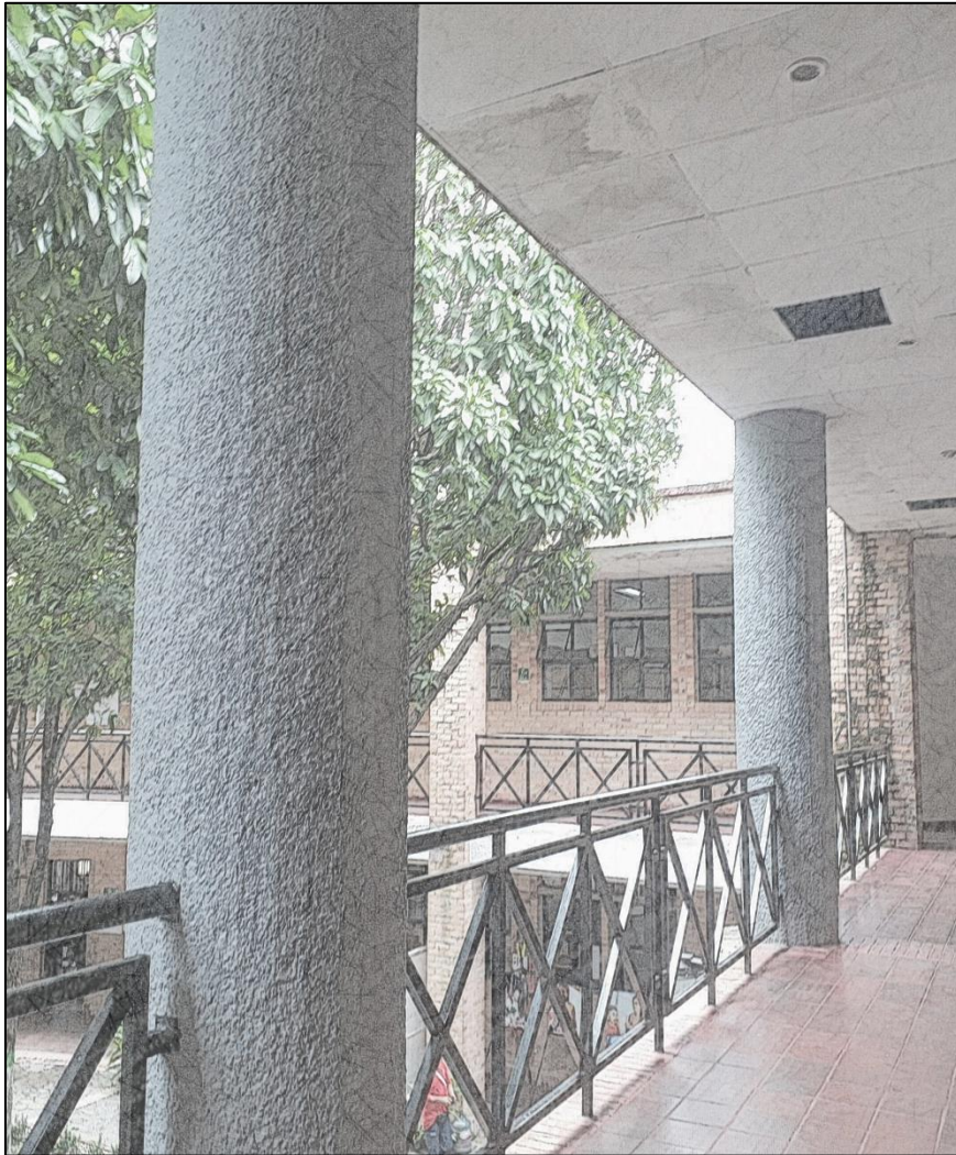
Fuente propia. Columnas 9 y 10 segundo nivel.
