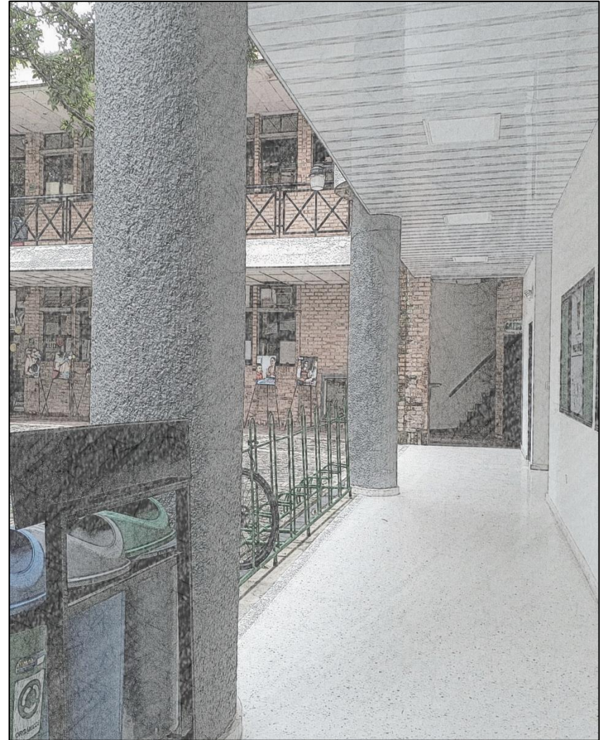
Fuente propia. Columnas 9 y 10 primer nivel.
