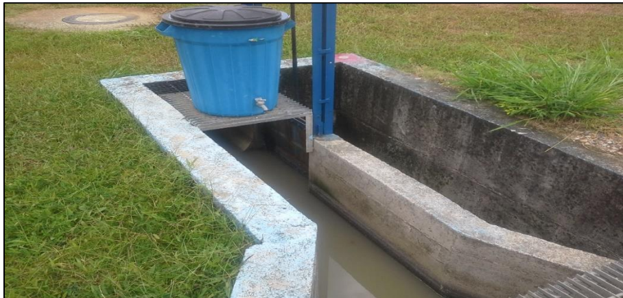
Figura 10. Fotografía cámara de llegada
