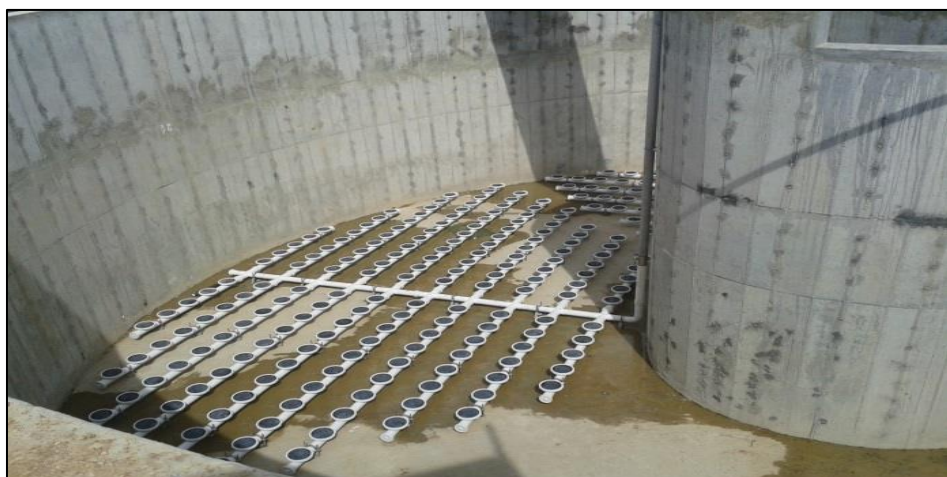
Figura 17. Fotografía sistema de difusión de aire de burbuja fina
