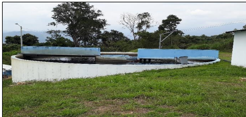
Fotografía tanque de aireación
