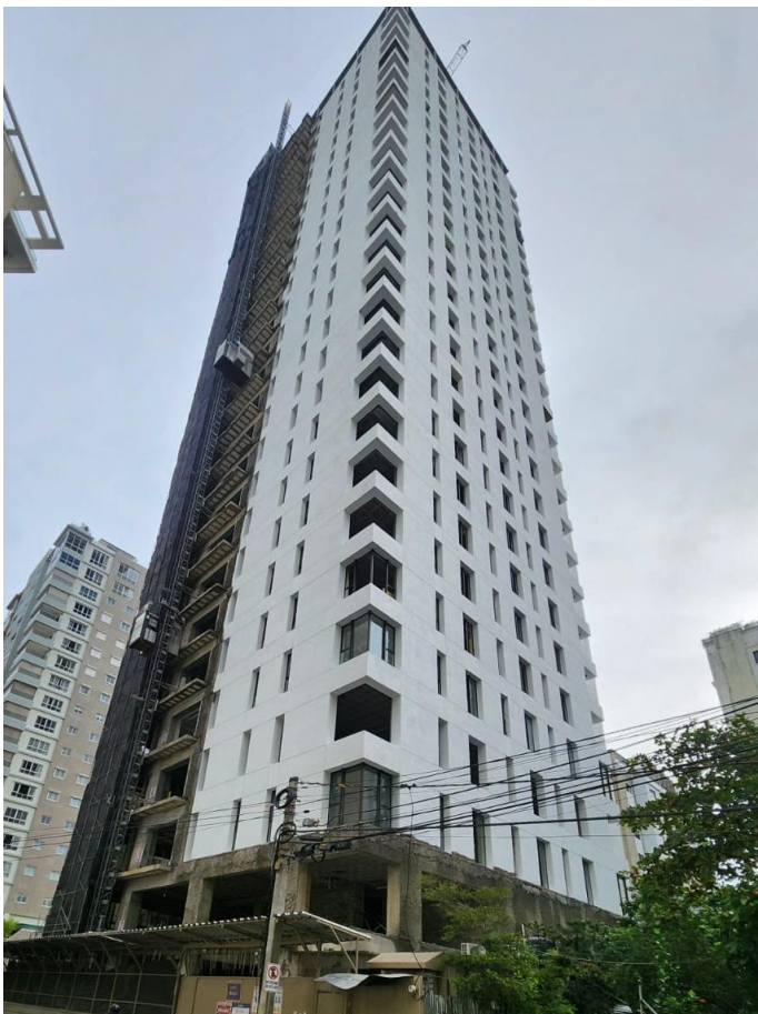
Imagen 5. Edificio con mampostería confinada y aporticado fuente: Propia
