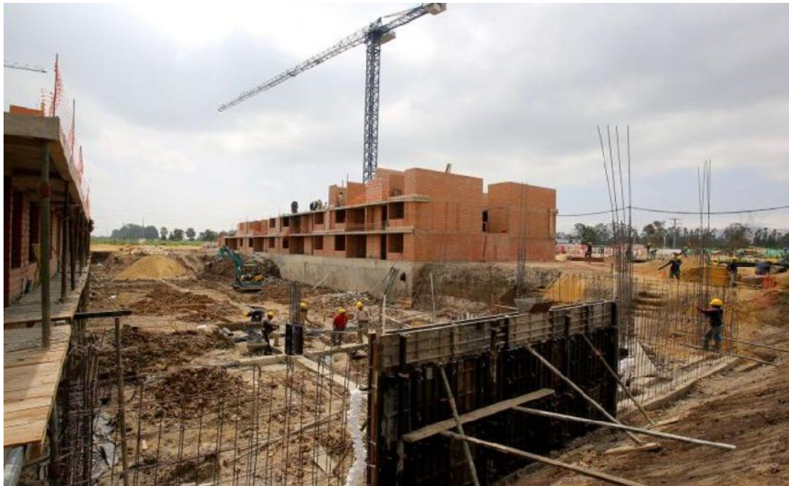
Ilustración 28. Proceso constructivo estructura de parqueaderos (Tomado de: https://www.constructoracapital.com/avance/89/nogal )
