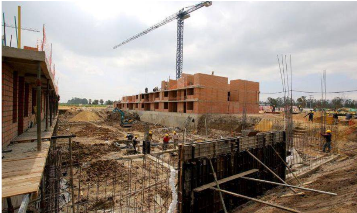
Ilustración 29. Excavación y cimentación del sótano (Tomado de: https://www.constructoracapital.com/avance/89/nogal/ )
