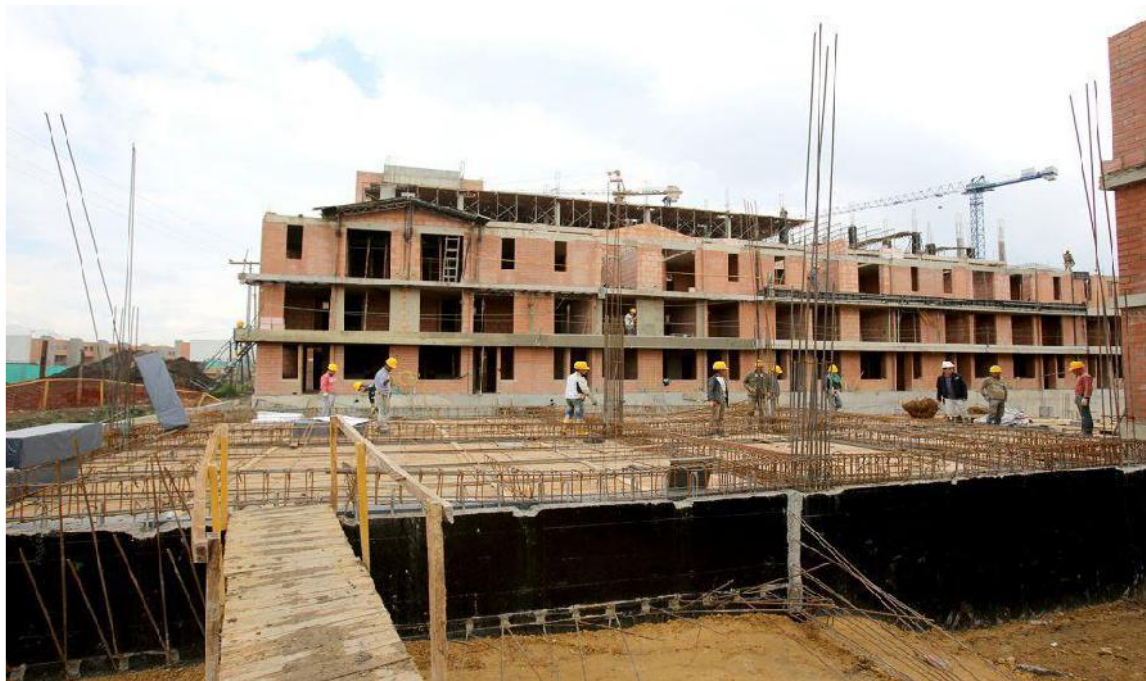
Ilustración 30. Disposición refuerzo vigas (Tomado de: https://www.constructoracapital.com/proyecto/2/bogota-y- alrededores/mosquera/89/nogal- )
