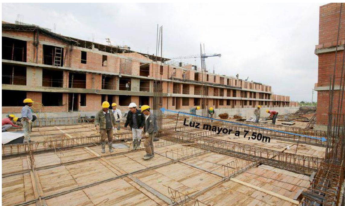
Ilustración 31. Refuerzo vigas aéreas (Tomado de: https://www.constructoracapital.com/proyecto/2/bogota-y-alrededores/mosquera/89/nogal- )
