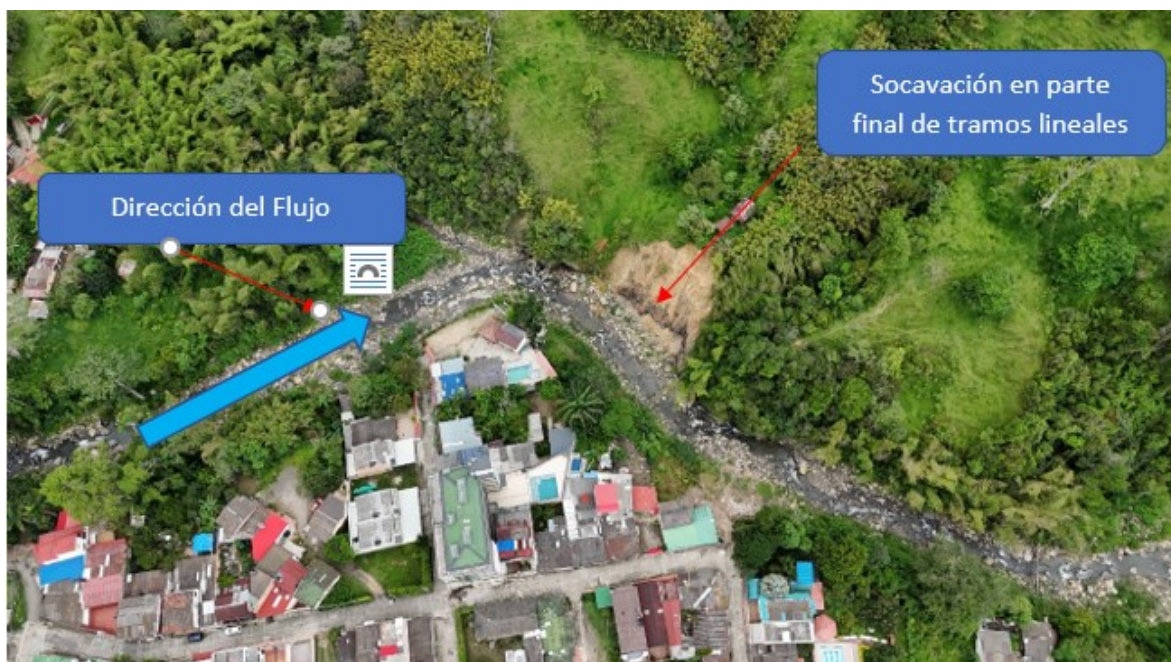
Figura 3 Procesos de socavación cauce río Ila, municipio de La Vega
