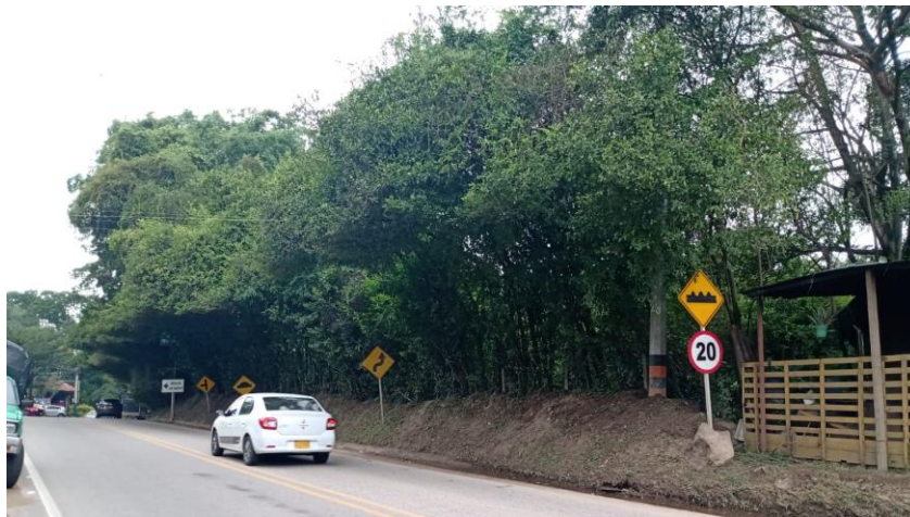
Figura 59 Autopista estado actual lote
