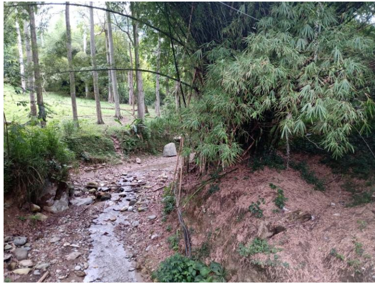
Figura 68 Quebrada La Venta 2022
