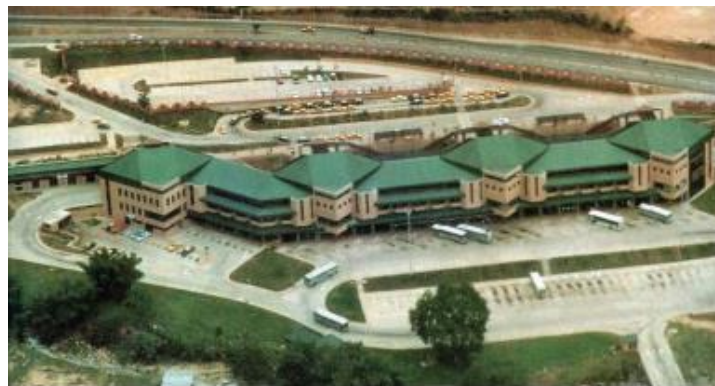
Figura 20 Módulo infraestructura Terminal de Bucaramanga
