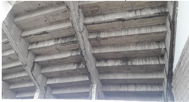
Imagen 10. Estructura graderia plaza de toros Pepe Cáceres
