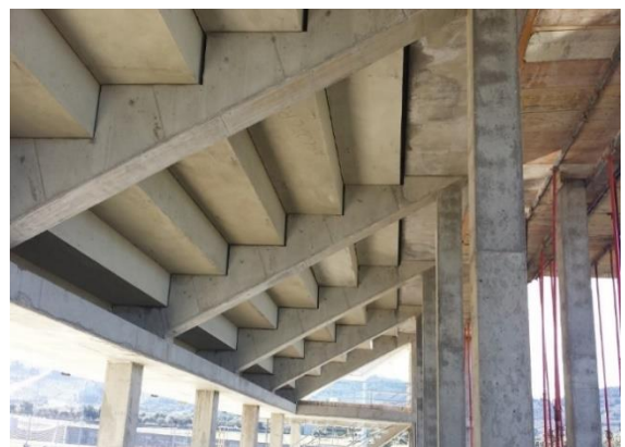
Imagen 9 Esquema de estructura para graderías
