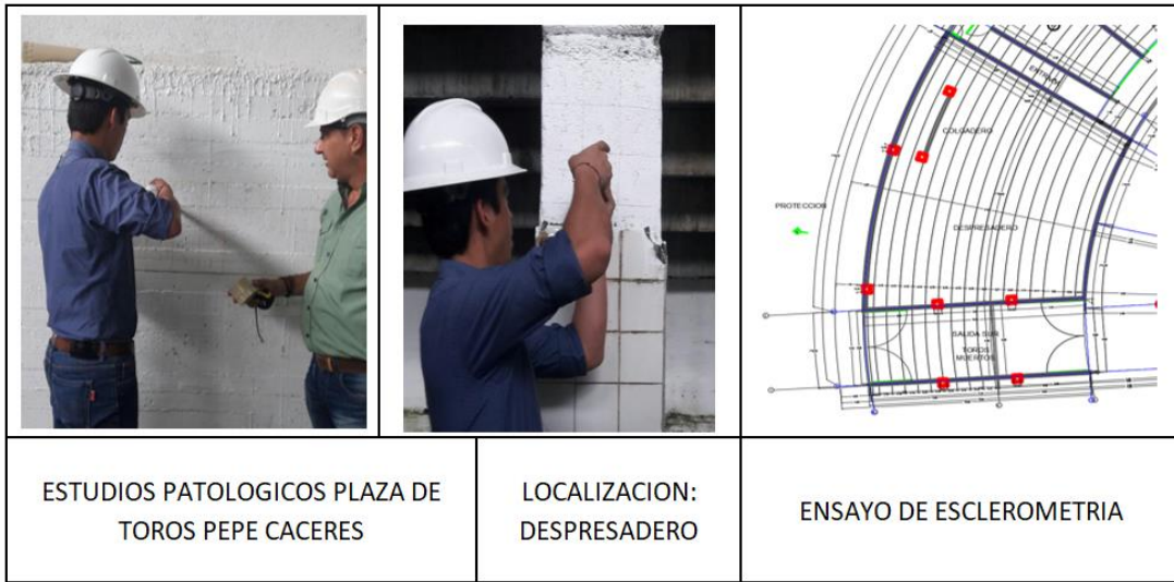
Imagen 20. Ensayo de esclerometria.
