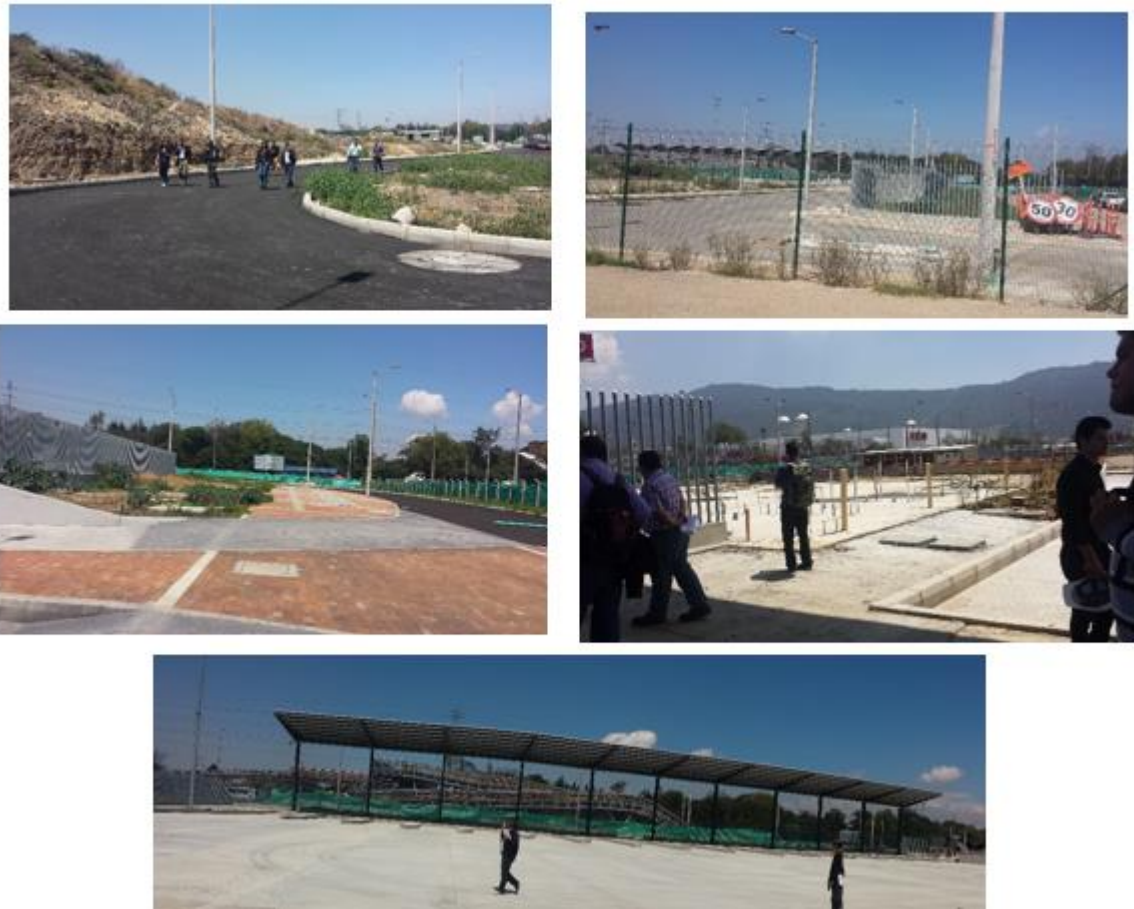
Figura 9. Terminal Satélite del Norte
