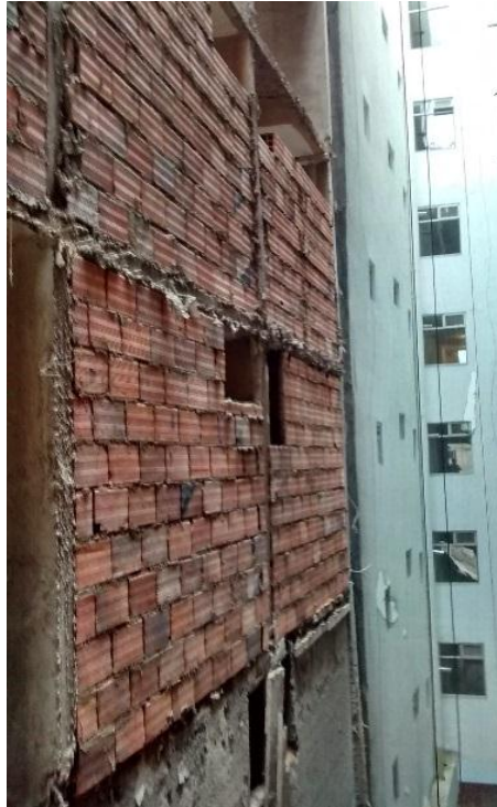
Fotografía 39. Mampostería costado posterior Torre E.
