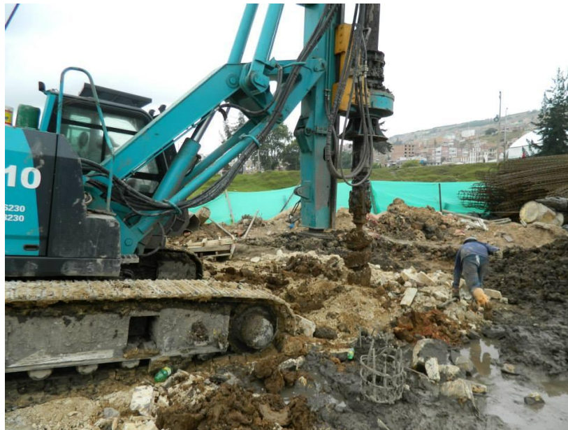
Fotografía 1. Proceso de perforación pilotes preexcavados Torre A
