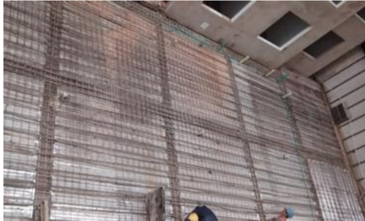
Fotografía 32. Extendida de malla electrosoldada para placa de areas comunes
