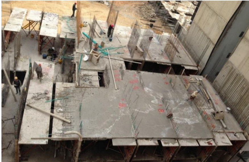
Fotografía 23. Fundida de tuneles Torre F.
