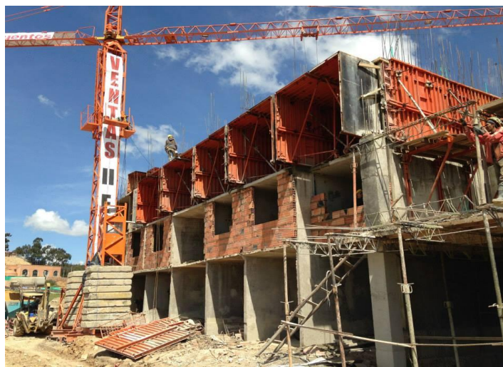
Fotografía 18. Encofrado outinord Torre A.
