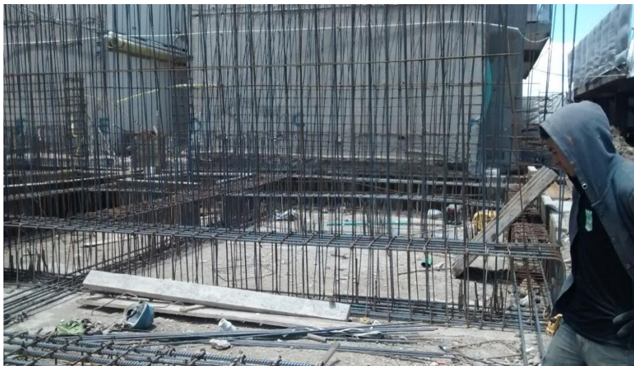
Fotografía 7. Anclaje de arranques de muros Torre C.
