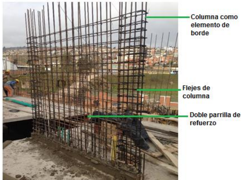
Fotografía 20. Muro con doble enmallado Torre E.
