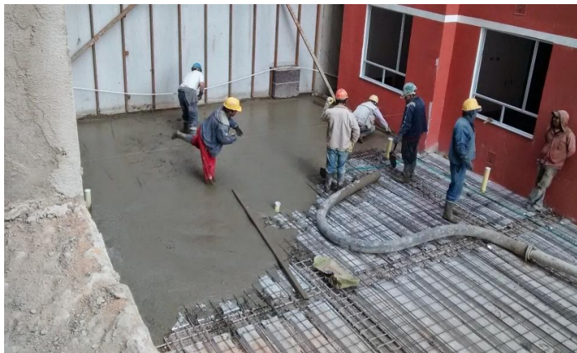
Fotografía 33. Vaciado de concreto para placa de areas comunes
