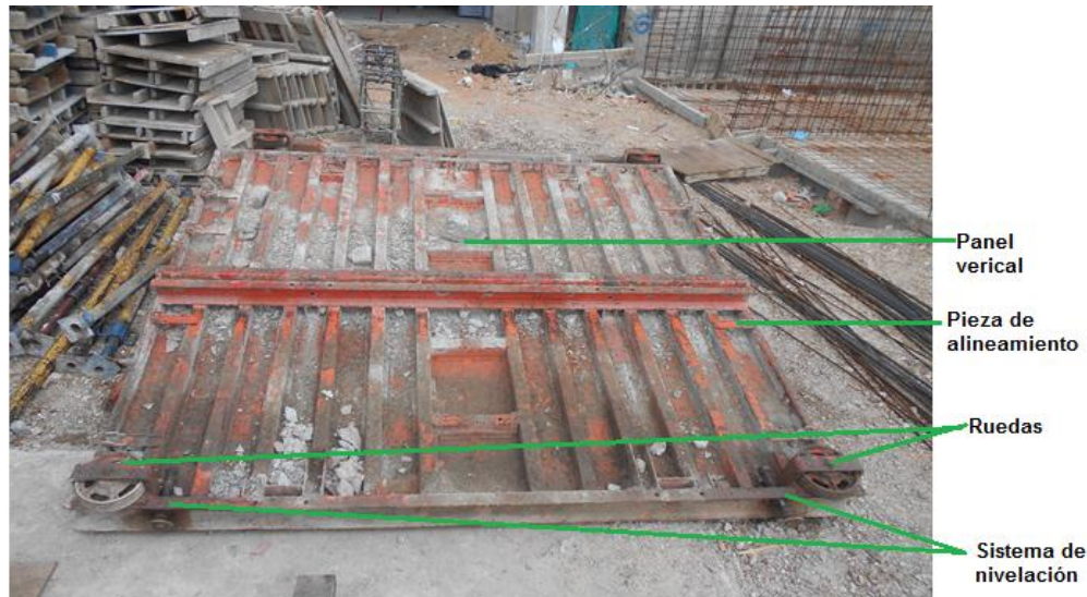
Fotografía 17. Partes de Accesorio de formaleta para muros outinord.
