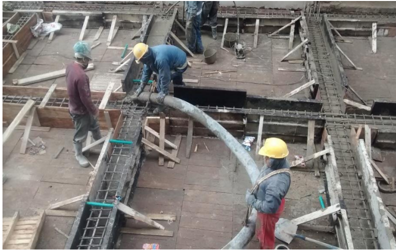
Fotografía 30. Vaciado de concreto de vigas de enlace placa de areas comunes
