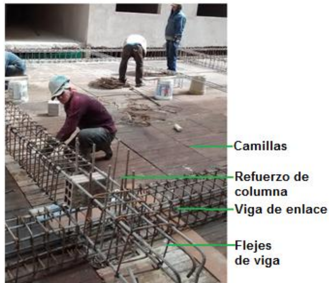
Fotografía 28. Armado de aceros de vigas de enlace para placa de areas comunes
