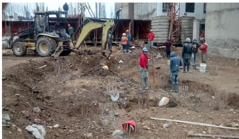
Fotografía 3. Demolición y enderezado de la cabeza del pilote Torre C.
