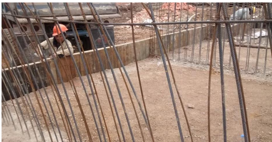
Fotografía 12. Colocación de camillas en los bordes Torre F.
