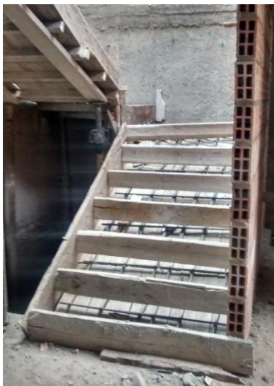
Fotografía 26. Armado de aceros y testeros de escaleras, Torre E.
