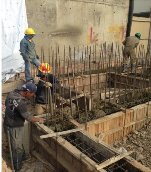
Fotografía 10. Fundida de vigas de cimentación Torre F.
