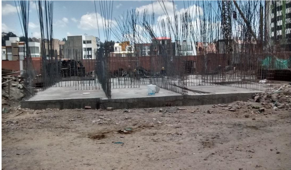
Fotografía 14. Losa Torre F.
