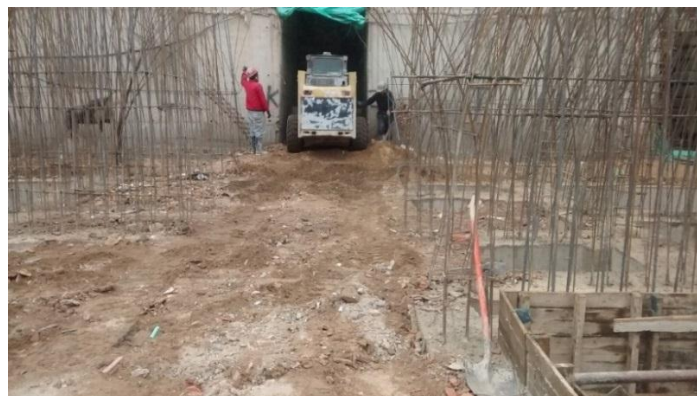
Fotografía 11. Compactación con material de relleno Torre F.
