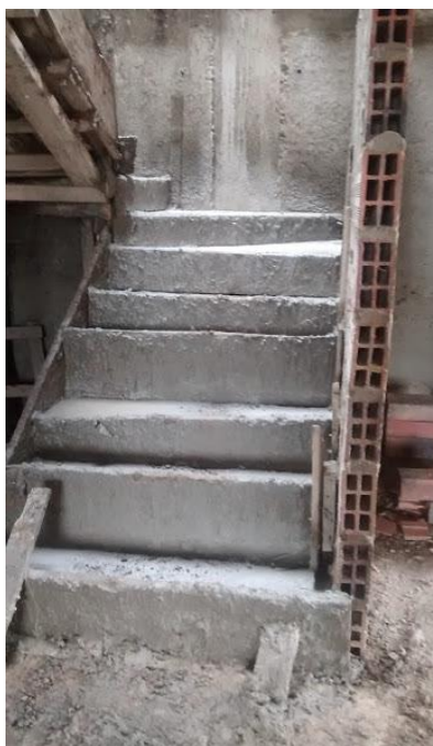
Fotografía 27. Fundida de escaleras, Torre E.
