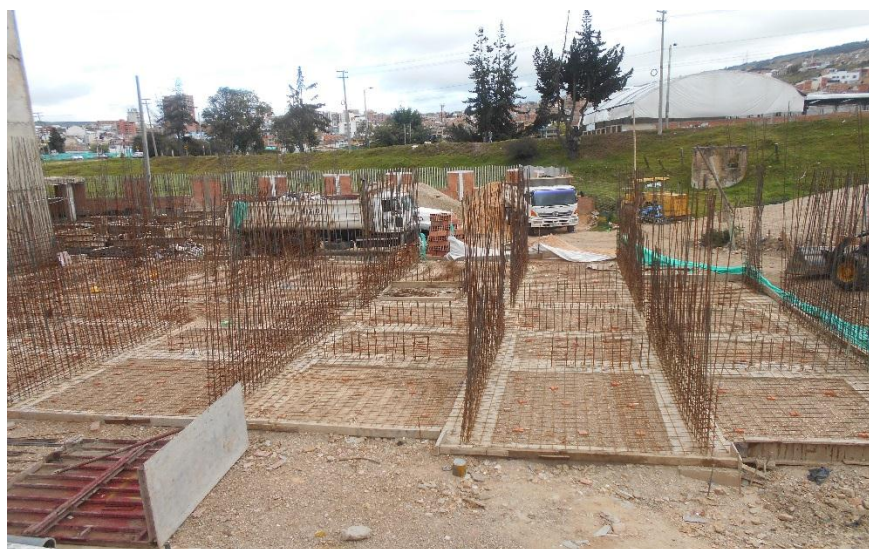
Fotografía 13. Aceros de refuerzo de losa Torre C.
