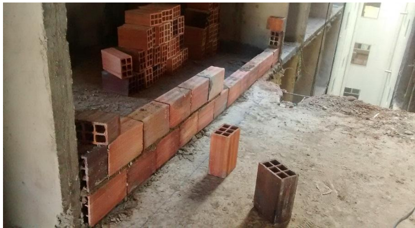
Fotografía 38. Hilada muerta de bloque Torre E.
