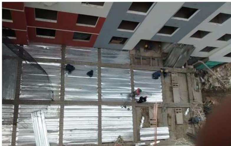
Fotografía 31. Instalación lamina steel deck para placa de areas comunes
