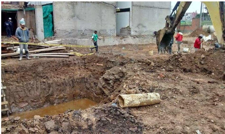
Fotografía 34. Excavación tanque de almacenamiento
