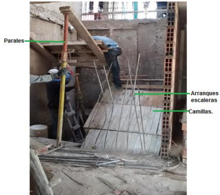
Fotografía 24. Instalación de camillas de escaleras Torre E.
