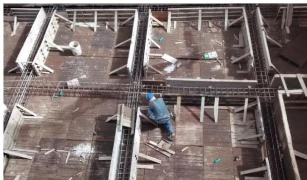
Fotografía 29. Armado de formaleta de vigas de enlace para placa de areas comunes
