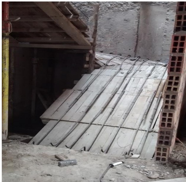
Fotografía 25. Traslapo y anclaje de aceros escaleras, Torre E.
