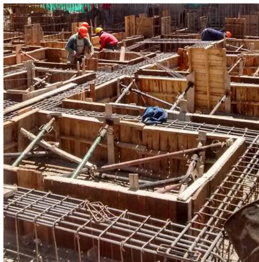
Fotografía 9. Armado de encofrado vigas de cimentación Torre C.
