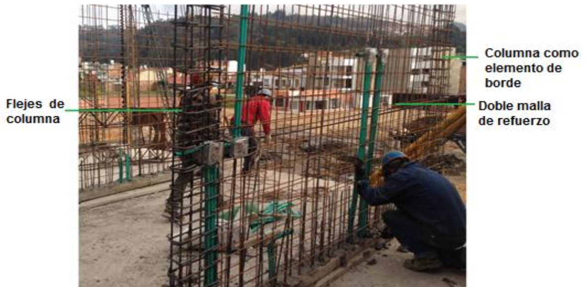
Fotografía 20. Muro con doble enmallado Torre E.
