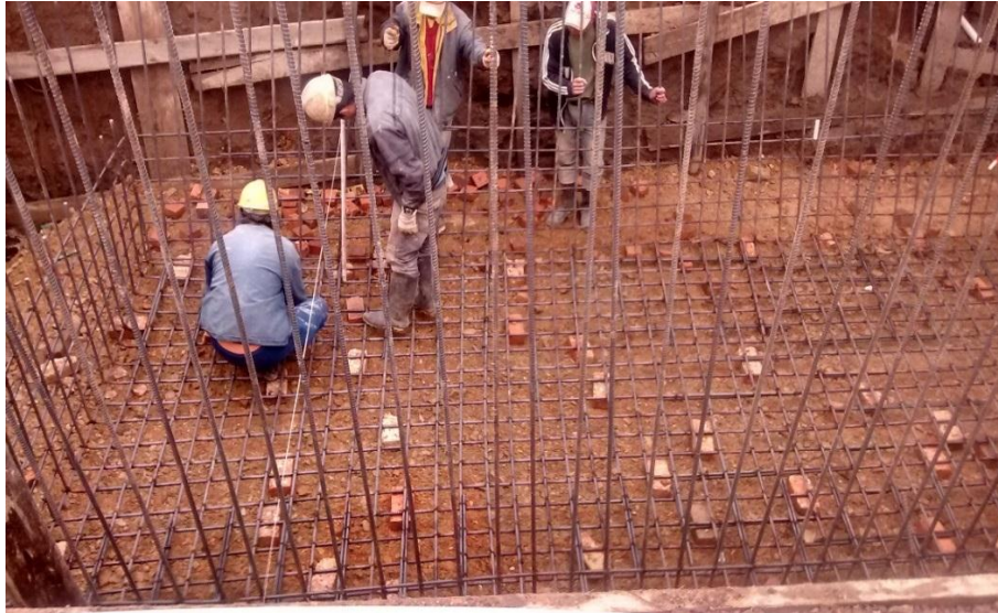
Fotografía 35. Armado de aceros de refuerzo tanque de almacenamiento
