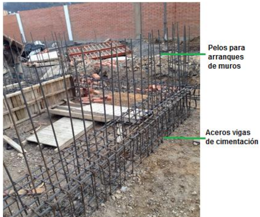
Fotografía 6. Anclaje de arranques de muros Torre F.
