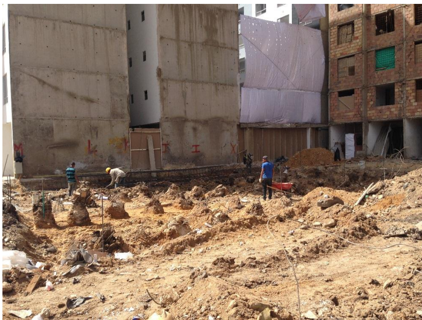
Fotografía 2. Demolición y enderezado de aceros de la cabeza del pilote Torre F.
