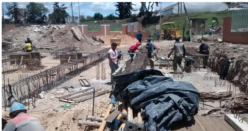
Fotografía 5. Armado de aceros de vigas de cimentación Torre C.
