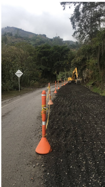
Fotografía 1. Estado de la capa de subbase antes y después de compactar.
