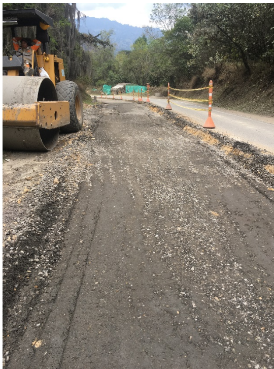
Fotografía 2. Estado de la capa de subbase antes y después de compactar.
