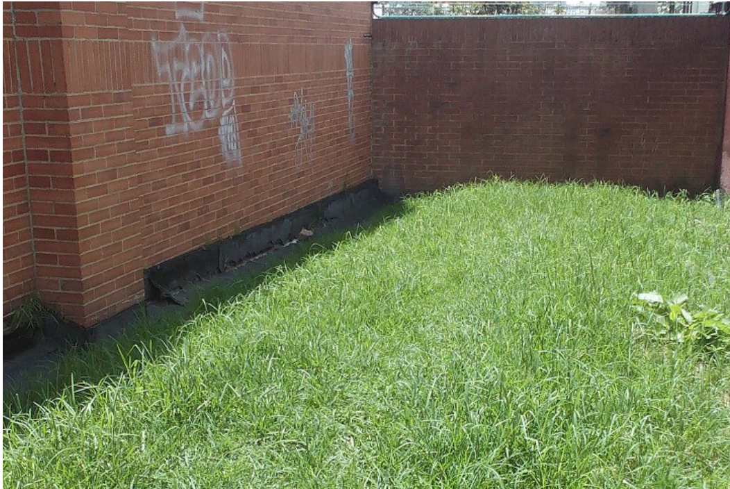
Figura. 5 Zona posterior a la oficina de administración
