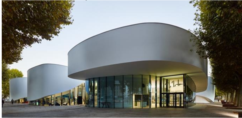
Figura 39. Fachada abierta en la recepción
