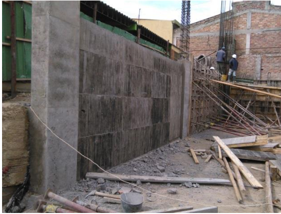
Fotografía 13. Desencofrado de columnas y muro. Fuente: Propia - 10 de octubre de 2015
