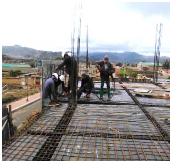
Fotografía 20. Amarre de acero placa segundo piso Aula Multiservicio. Fuente: Propia - 30 de octubre de 2015
