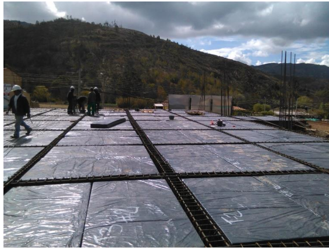
Fotografía 19. Instalación de casetón placa entre piso. Fuente: Propia - 30 de octubre de 2015
