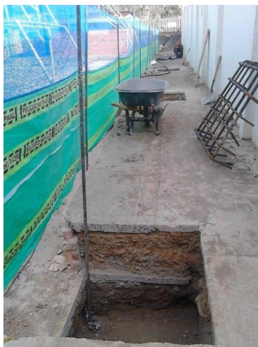
Fotografía 26. Excavación manual para zapatas de cubierta. Fuente: Propia
