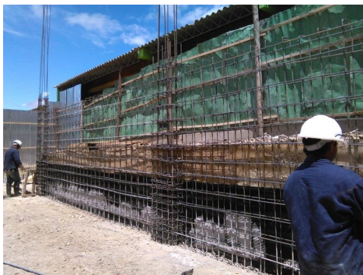
Fotografía 10. Refuerzo de columnas y muro pantalla. Fuente: Propia
