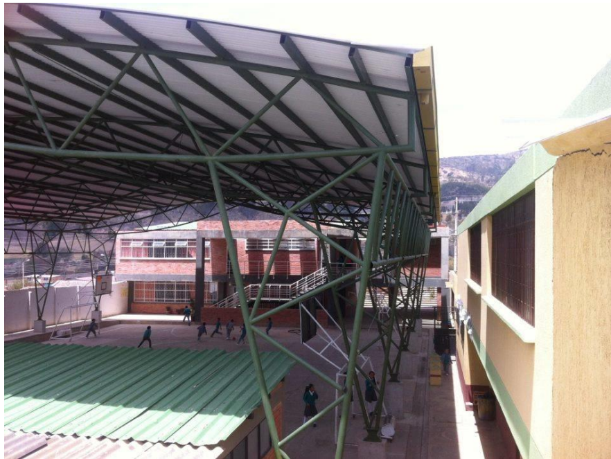
Fotografía 30. Cubierta cancha Colegio de Sora. Fuente: Propia - 12 de diciembre de 2015
