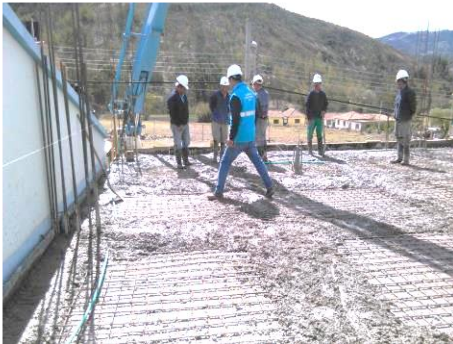
Fotografía 21. Fundida vigas placa de entre piso. Fuente: Propia - 11 de noviembre de 2015
