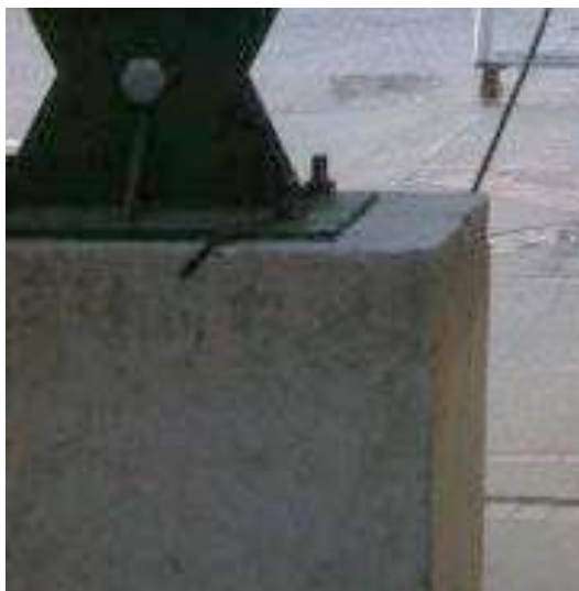
Fotografía 29. Anclaje estructura metálica para cubierta Cancha Colegio de Sora y Escuela Pita Chone. Fuente: Propia
