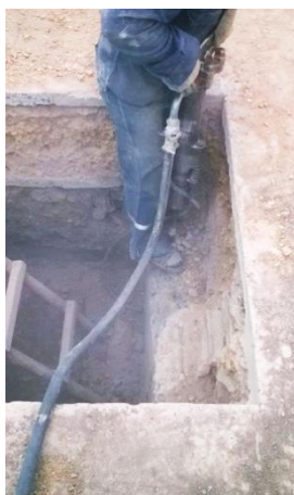
Fotografía 25. Martillo Percutor para excavación de zapatas. Fuente: Propia
