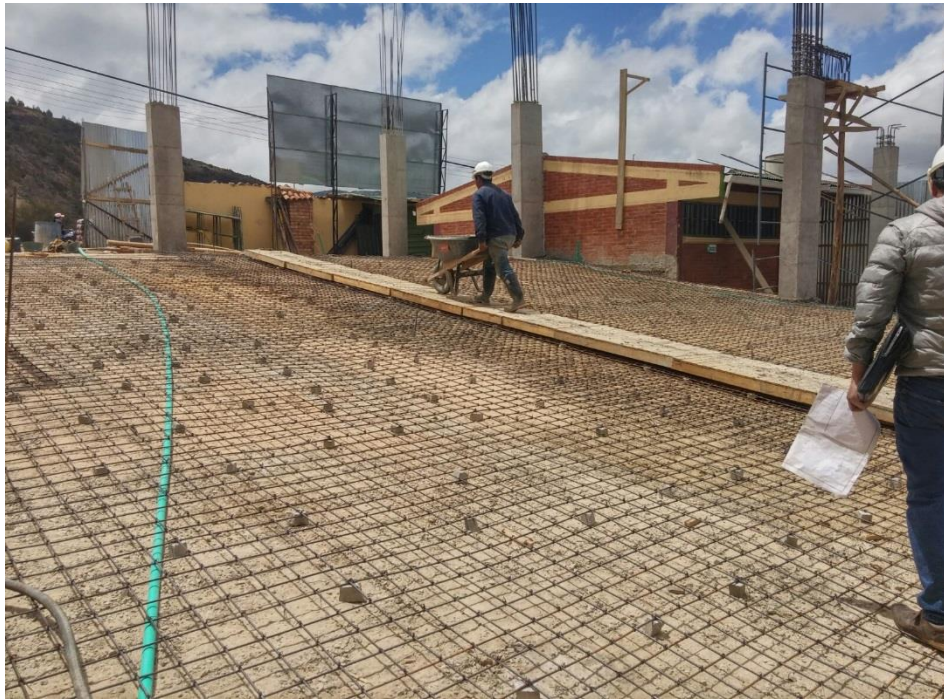
Fotografía 15. Armado del refuerzo placa de contrapiso. Fuente: Propia
