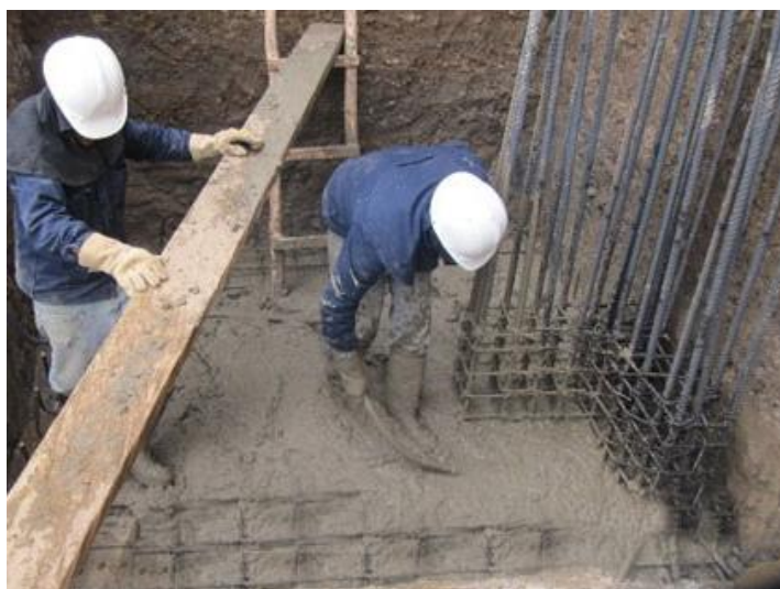
Fotografía 8. Refuerzo zapatas Aula Multiservicio. Fuente: Propia - 30 de septiembre de 2015
