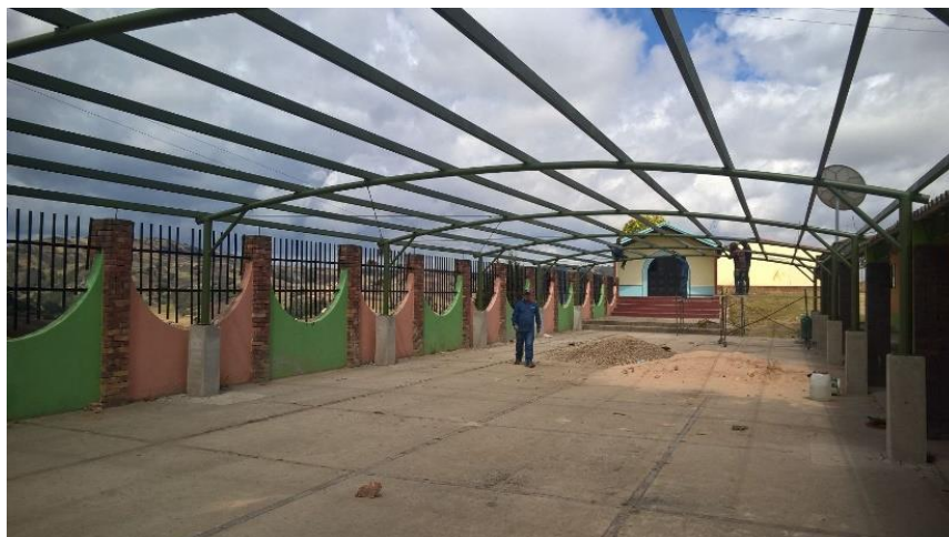
Fotografía 31. Estructura cubierta cancha Escuela Pita y Chone. Fuente: Propia
