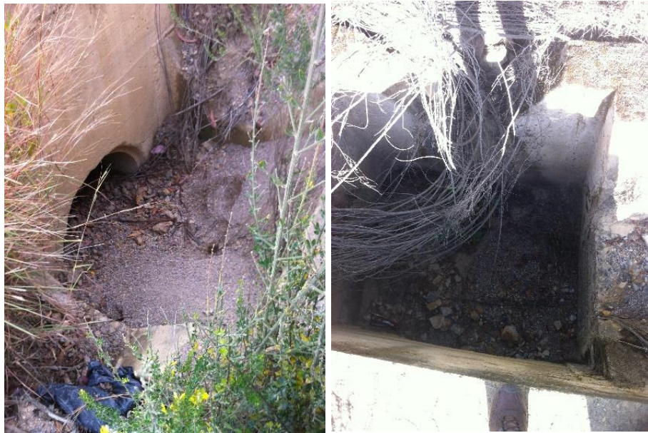
Fotografía 35. Alcantarillas existentes. Fuente: Propia
