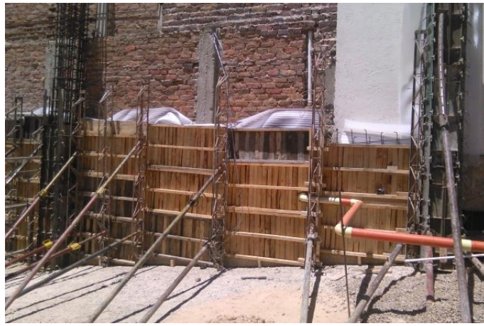
Fotografía 11. Armado de formaleta. Fuente: Propia - 30 de septiembre de 2015
