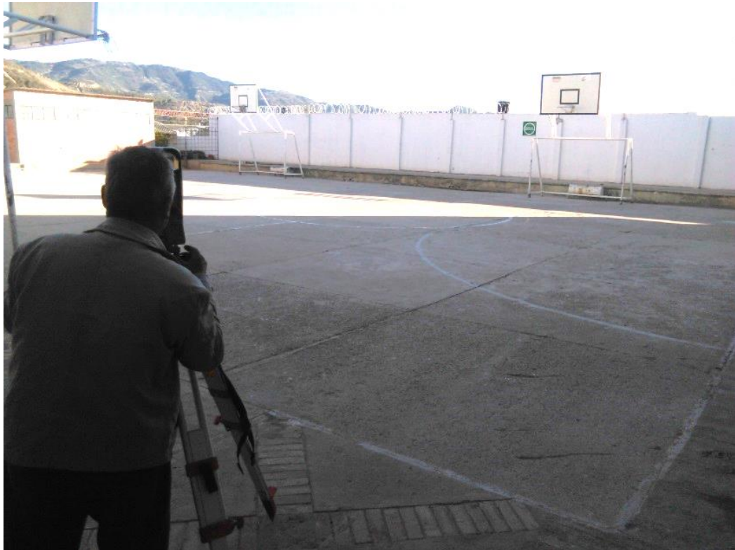
Fotografía 23. Localización y replanteo Cancha del Colegio Sora. Fuente: Propia
