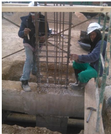
Fotografía 9. Viga de cimentación Aula Multiservicio. Fuente: Propia
