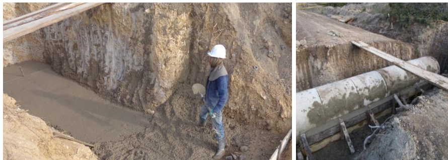
Fotografía 42. Proceso constructivo para solado y atraques. Fuente: Propia – 19 de noviembre de 2015
