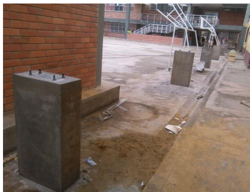
Fotografía 28. Pedestal Cubierta Cancha Colegio de Sora. Fuente: Propia
