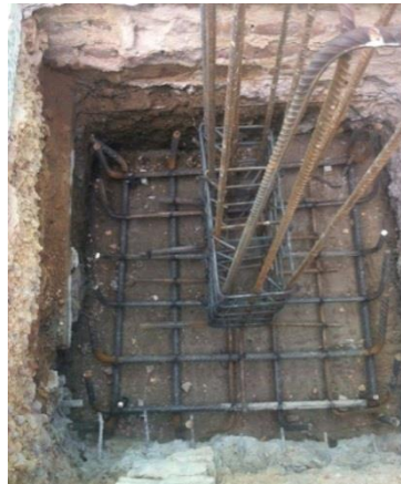
Fotografía 27. Refuerzo de zapatas y pedestales Cubierta Colegio de Sora. Fuente: Propia - 4 de noviembre de 2015
