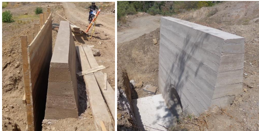
Fotografía 45. Fundida de muro de salida. Fuente: Propia
