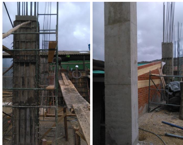
Fotografía 12. Armado de formaleta para columnas. Fuente: Propia - 30 de septiembre de 2015
