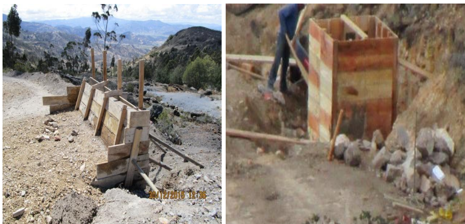
Fotografía 43. Formaleta para caja de entrada y muro de salida. Fuente: Propia – 11 de noviembre de 2015
