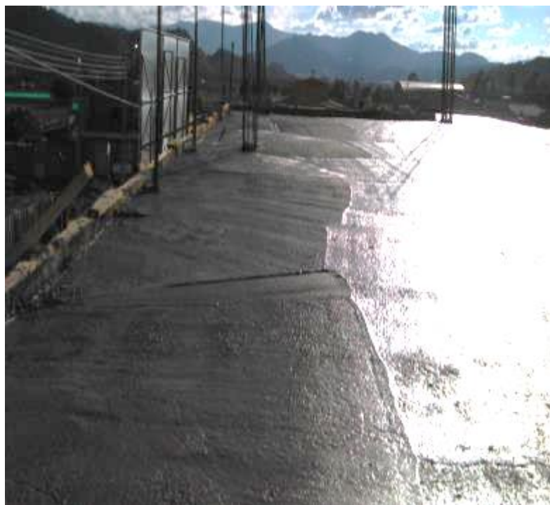
Fotografía 22. Fundida placa entre piso. Fuente: Propia
