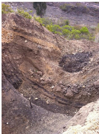
Fotografía 40. Excavación para muro, descole y muela. Fuente: Propia - 16 de noviembre de 2015
