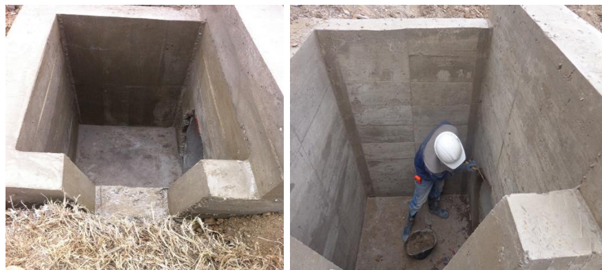
Fotografía 46. Fundida de caja de entrada. Fuente: Propia
