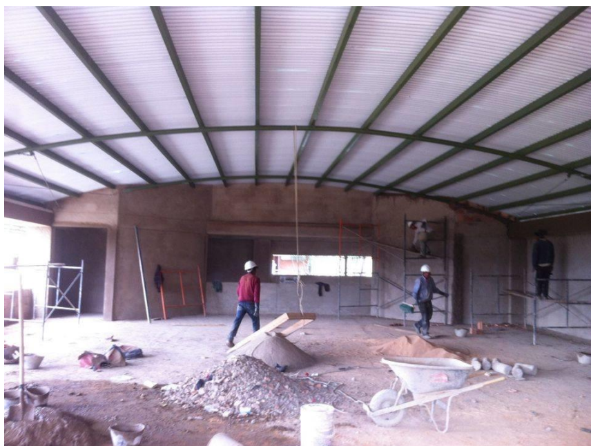
Fotografía 32. Cubierta Aula Multiservicio. Fuente: Propia
