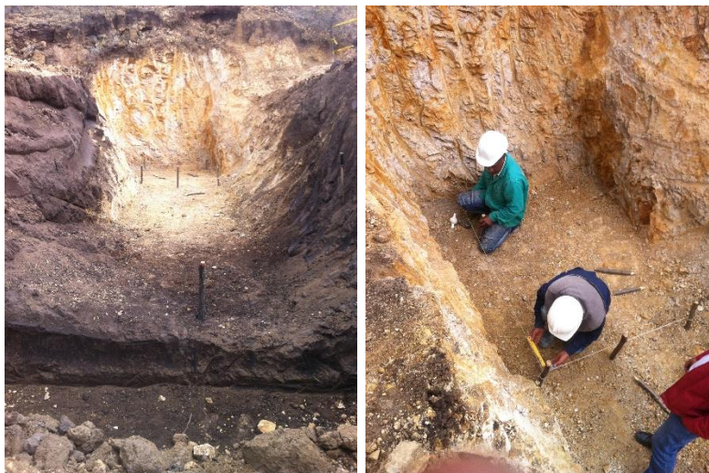
Fotografía 41. Excavación para cuerpo y caja. Fuente: Propia
