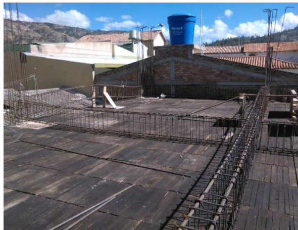
Fotografía 18. Refuerzo longitudinal y distribución de flejes placa entre piso. Fuente: Propia
