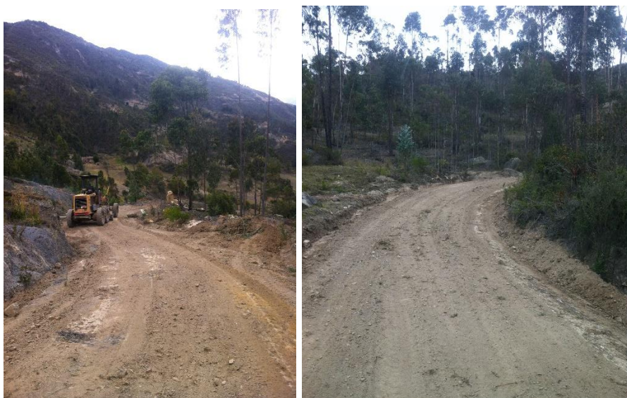
Fotografía 39. Perfilado y cuneteo de la banca existente. Fuente: Propia - 5 de noviembre de 2015
