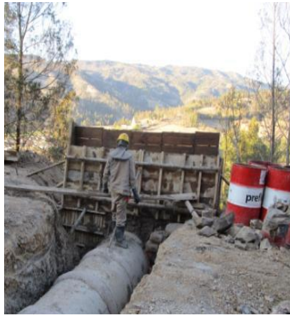
Fotografía 44. Construcción de formaleta. Fuente: Propia – 30 de noviembre de 2015
