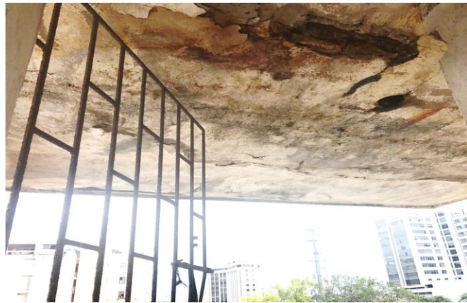
DETALLE DESPRENDIMIENTOS, CORROSION DE LOS ACEROS, PERDIDA DE SECCION.
