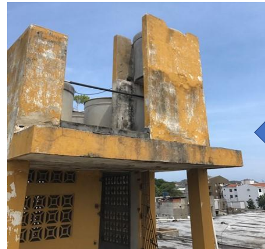
DETALLE DESPRENDIMIENTOS, CORROSION DE LOS ACEROS, PERDIDA DE SECCION.
