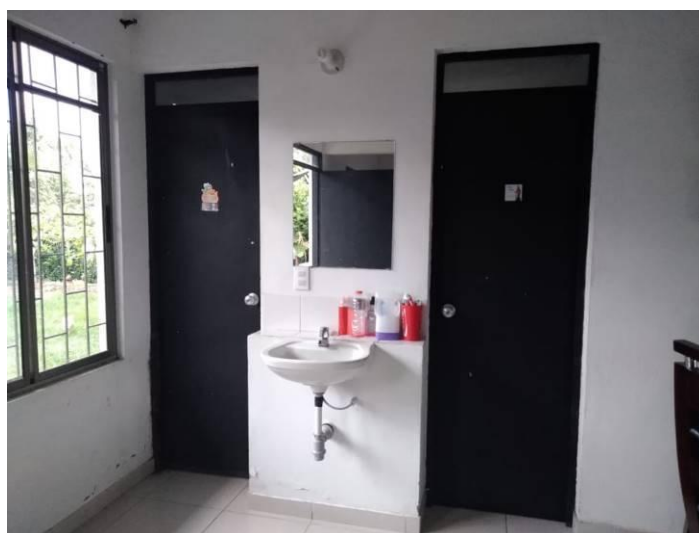
Figura 14. Baño de una vivienda- Reasentamiento Nuevo Veracruz
