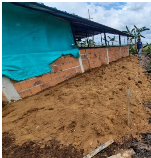
Figura 14. Construcción del piso y encierro del biodigestor.
