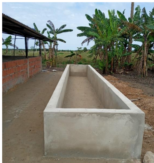
Figura 14. Construcción del piso y encierro del biodigestor.
