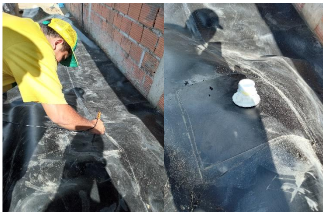
Figura 15. Instalación del flanche para el conducto del biogás.
