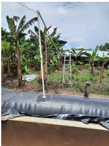
Figura 23. Instalación de la tubería del biodigestor.
