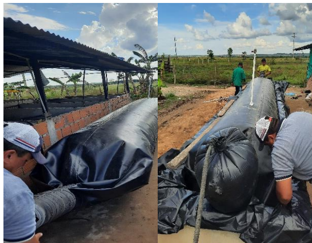
Figura 19. Instalación de la geo membrana.
