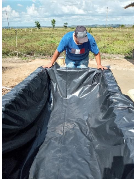
Figura 18. Instalación de la protección con plástico.
