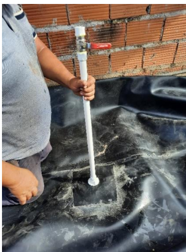
Figura 17. Adaptación del empalme del flanche con la tubería.
