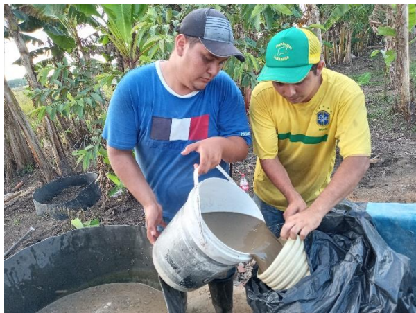
Figura 22. Primera carga de la mezcla excretas/agua.
