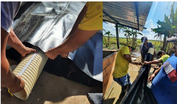
Figura 16. Adaptación del ducto de entra y salida.
