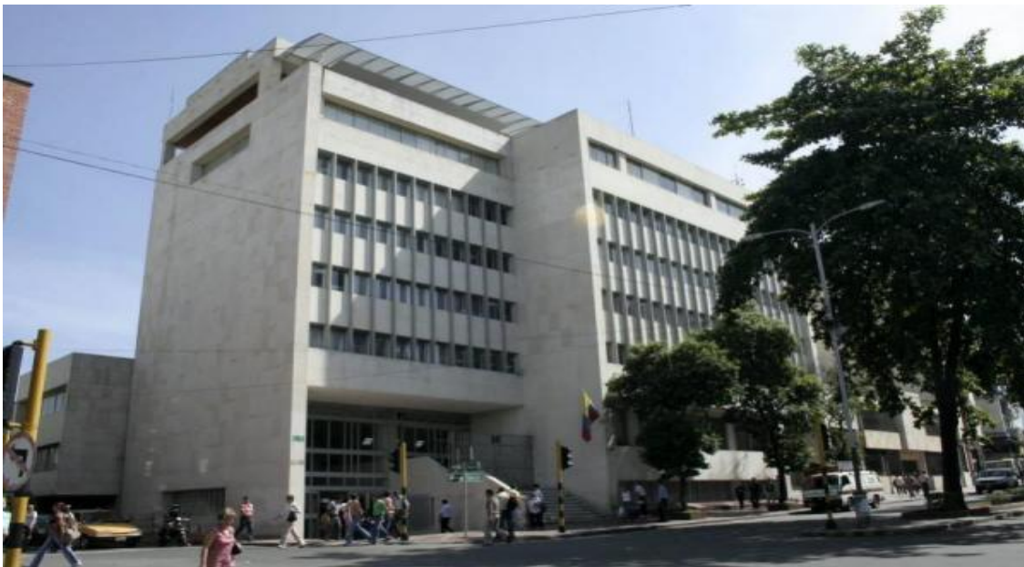
Figura 2. Edificio Dirección de Impuestos y Aduanas Nacionales Seccional Bucaramanga.
