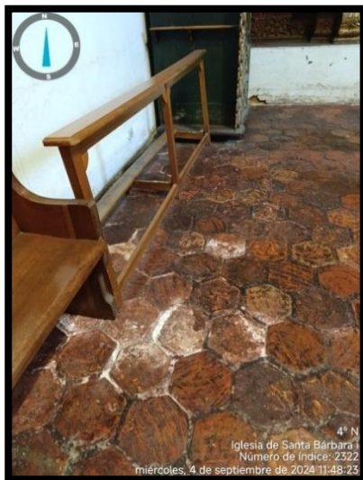
Figura 29. Presencia de sales en la superficie del piso con material cerámico poroso
