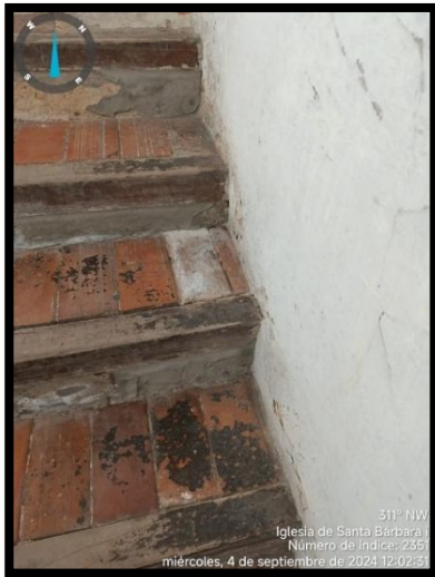
Figura 30. Presencia de sales en la superficie del piso con material cerámico poroso
