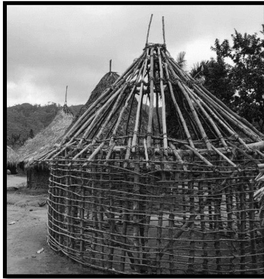
Figura 10. El bahareque sistema constructivo que respeta el medio ambiente.
