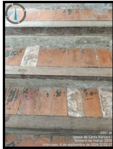
Figura 30. Presencia de sales en la superficie del piso con material cerámico poroso
