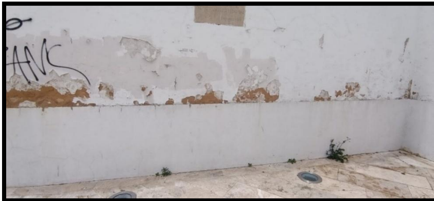
Figura 13. Aspecto que presenta el zócalo, con protección de cementos y aditivos para prevenir la humedad
