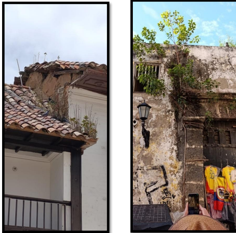
Figura 20. Humedades descendentes, provenientes de las cubiertas, con presencia de vegetación concentrándola aún más. Casas en Tunja y Cartagena
