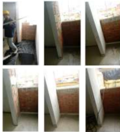
Figura 65. Mochetas de los tramos de fachada realizados en este corte
