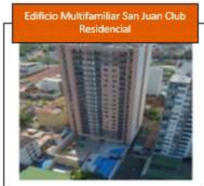
Figura 4. Edificio multifamiliar San Juan club residencial
