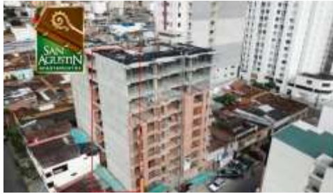
Figura 70. Tramo de culatas en el sector norte de la obra
