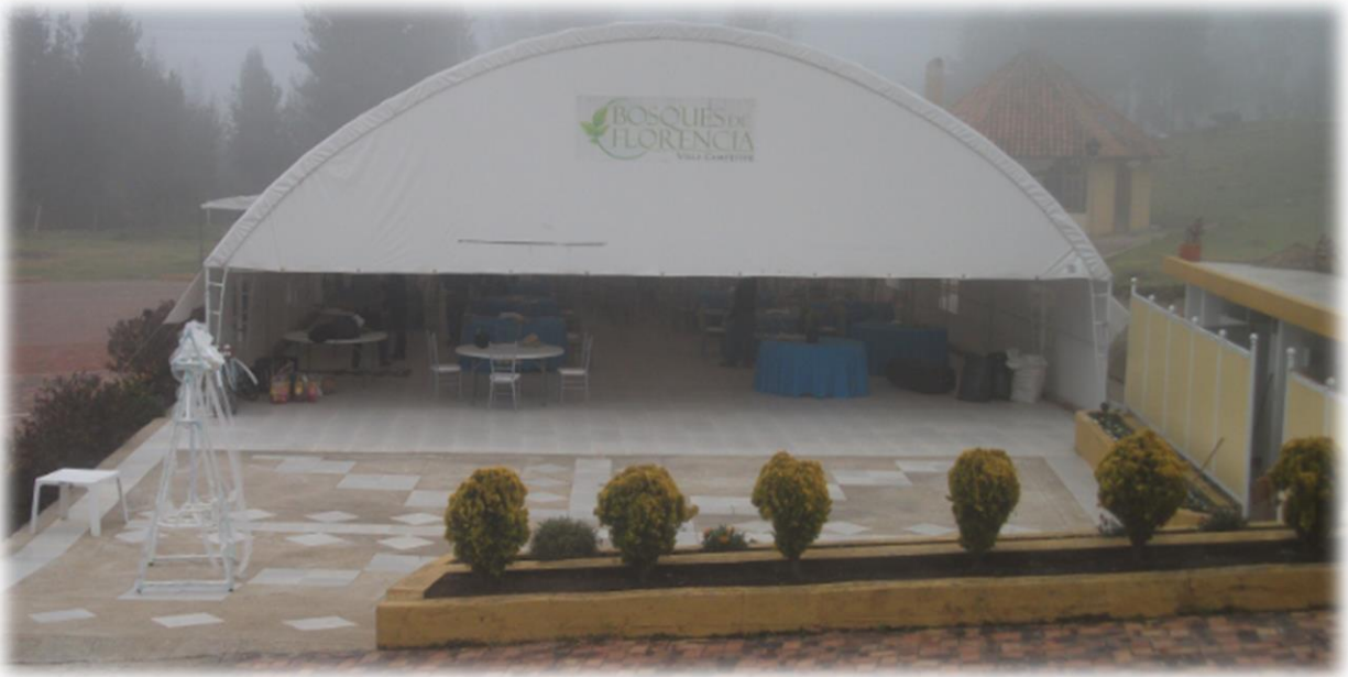
Fotografía de edificación Hangar
