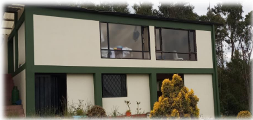
Fotografía de edificación Lavandería
