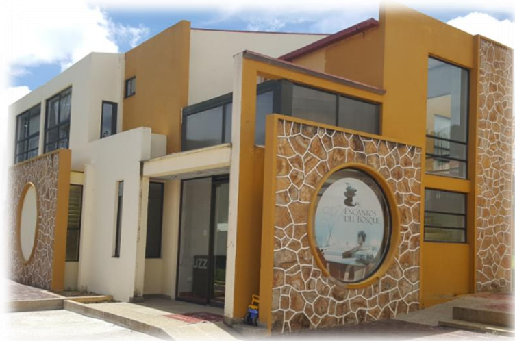
Fotografía de edificación SPA
