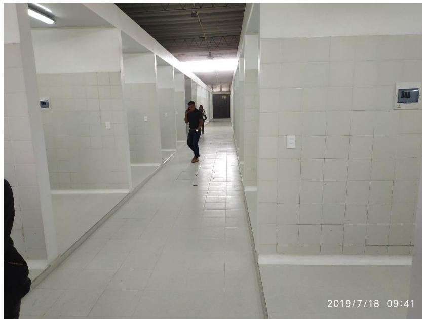
Imagen 1. Módulos de Cárnicos y Cocinas Plaza del Sur
