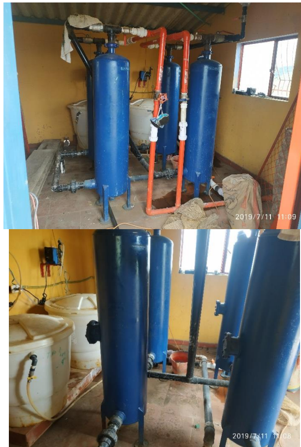
Imagen 15. Ptap tanques en fibra de vidrio elaborados por Eduardoño tipo 3
