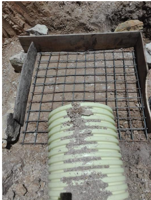
Imagen 10. Placa pozo de inspección, imagen 11. Pozo de inspección ya impermeabilizado
