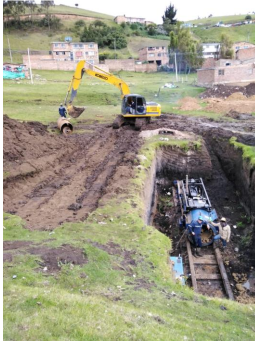
Imagen 12 Tuneladora de 50 pulgadas de diámetro en su rotor principal
