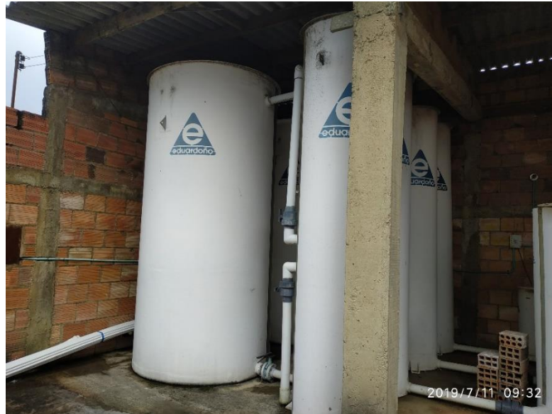
Imagen 16. Ptap tanques en fibra de vidrio elaborados por Eduardoño tipo 2
