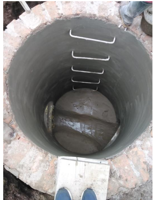
Imagen 10. Placa pozo de inspección, imagen 11. Pozo de inspección ya impermeabilizado
