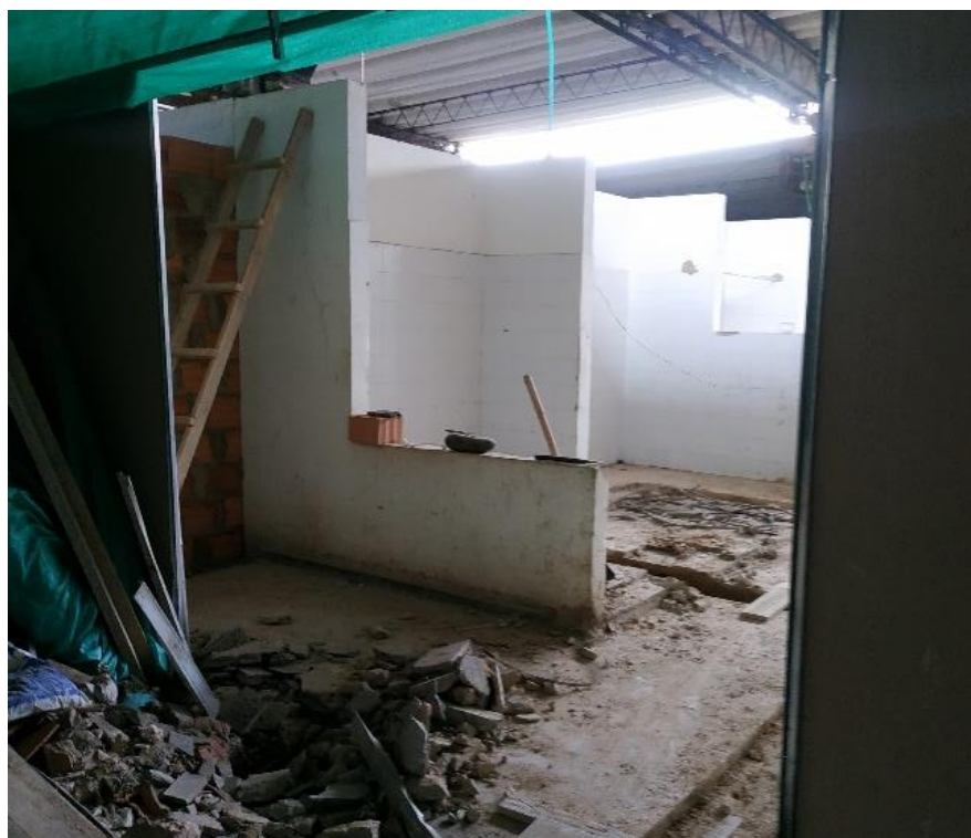
Imagen 6. Remodelación de concina plaza del sur
